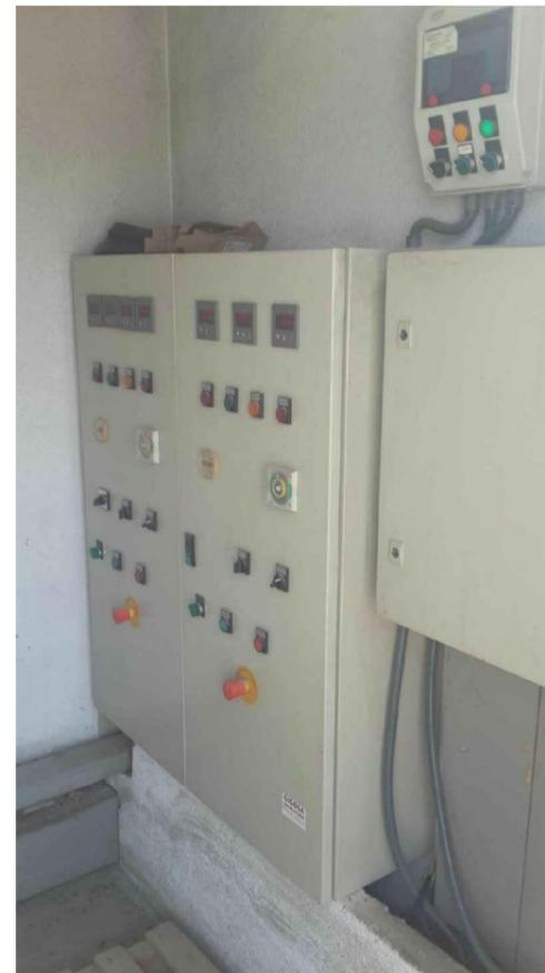
FOTO 04 - CUADROS CONTROL DE BOMBAS Y SECCIONADOR
