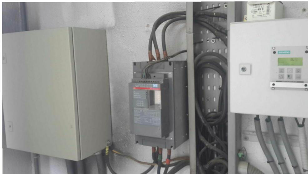
FOTO 03 - BATERÍA DE CONDENSADORES, ARRANCADOR ESTÁTICO Y CONTADOR
