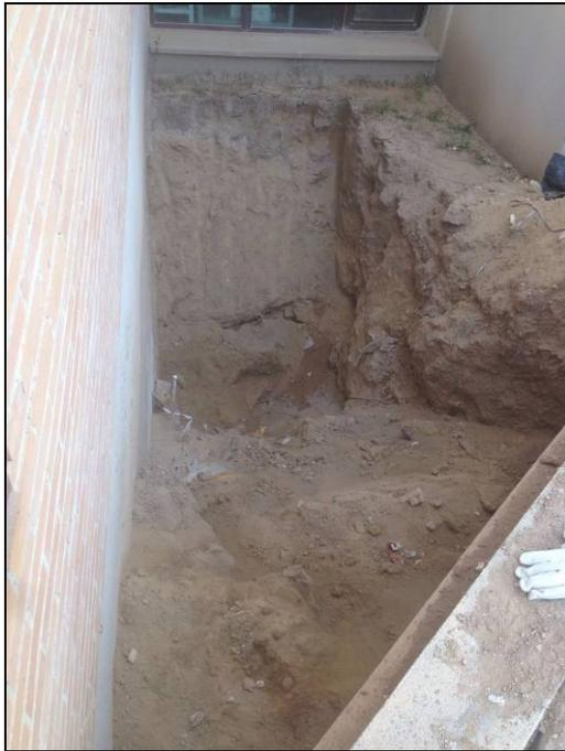
Extracción de los materiales de relleno hasta alcanzar el hormigón que ofreció rechazo en el ensayo D.P.S.H.
