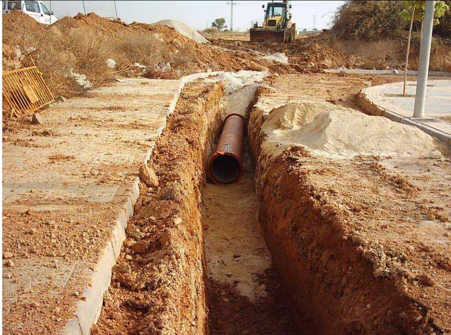
(Sept-2005) Impulsión de EBAR Severo Ochoa en su tramo próximo a la EBAR Barrio Peral. Se observa la estabilidad de las paredes de la zanja.
