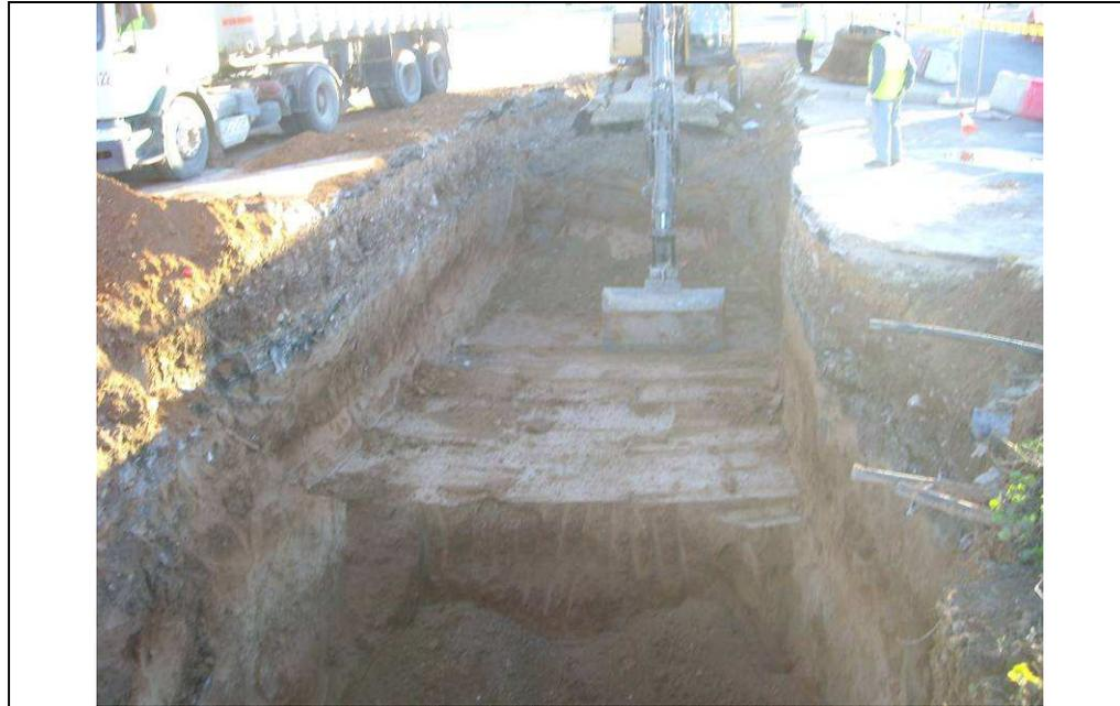
(Ene-2011) Excavación frente a la gasolinera de Severo Ochoa en la construcción del Interceptor de Residuales de Ronda Unión. Salvo el primer metro de rellenos, las paredes del talud son estables.
