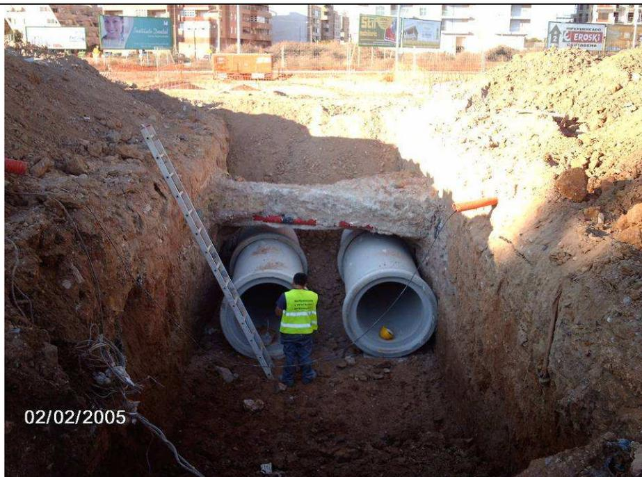
(Feb-2005) Ejecución de los aliviaderos actuales de la EBAR Severo Ochoa. Se observa la estabilidad de las paredes de la zanja.
