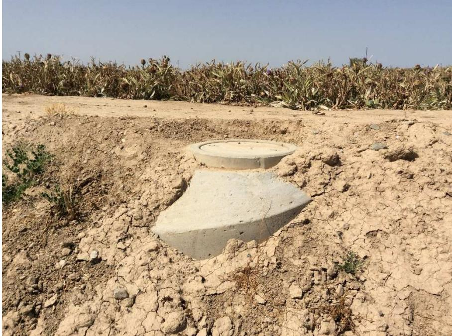
Fotografía 23. Pozo de registro de entronque del colector proyectado con colector principal que discurre por la Rambla de Biznaga. (P.K. 2+065)
