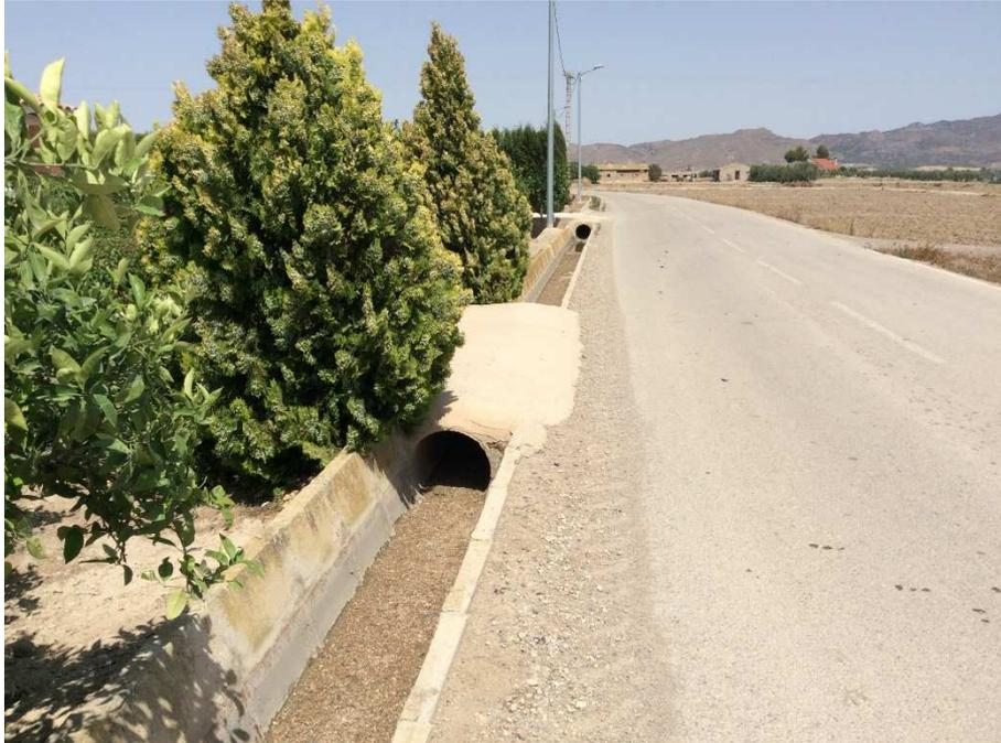
Fotografía 17. Canal de riego junto a borde de camino. Se observa también postes de alumbrado próximos a borde de camino. (P.K. 1+140)
