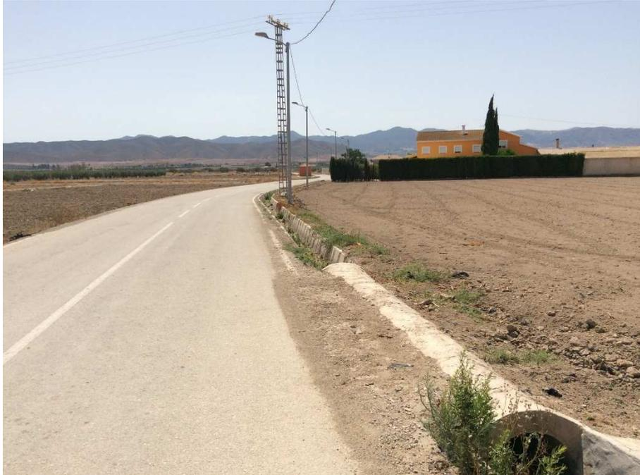
Fotografía 15. Proximidad de torre de línea de media tensión al camino de los Pastores. Canal de riego junto a borde de camino. (P.K. 1+030)
