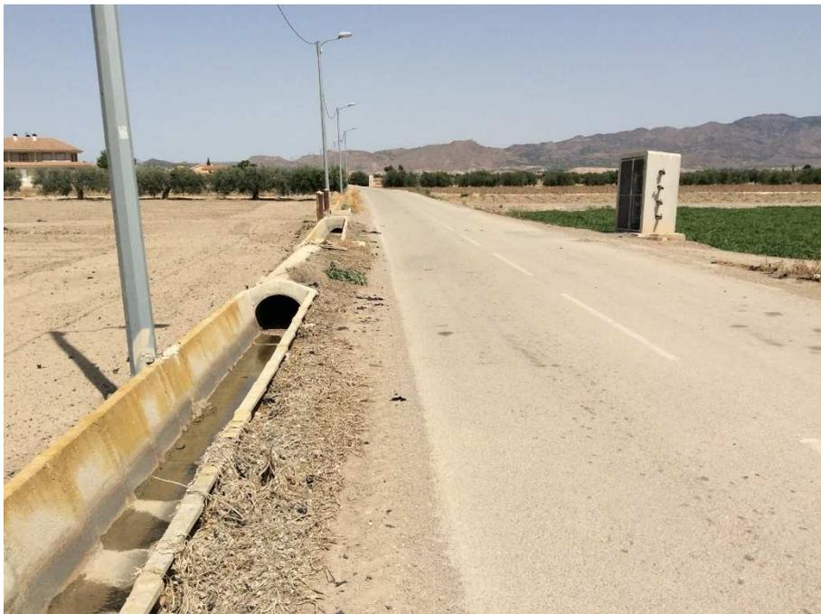
Fotografía 20. Postes de alumbrado junto a camino y traza del colector proyectado. Armario de riego de la CR Lorca. (P.K. 1+380)
