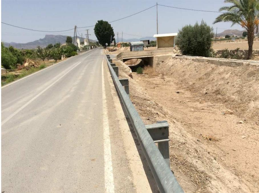
Fotografía 5. Brazal de riego de la CR Lorca a cruzar con colector. (P.K. 0+310)
