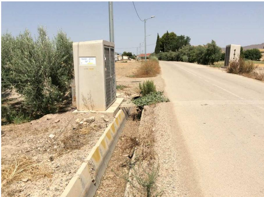
Fotografía 14. Armarios de riego de la CR Lorca con cruces bajo calzada del camino. (P.K. 0+990)
