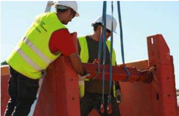
Como en la parte inferior, se aseguran los codales golpeando las cuñas con la maza, se repasan todas las cuñas y tornillos y se mide la distancia entre paneles, que deberá ser 4 o 5 cm menor que en el panel de corte.
