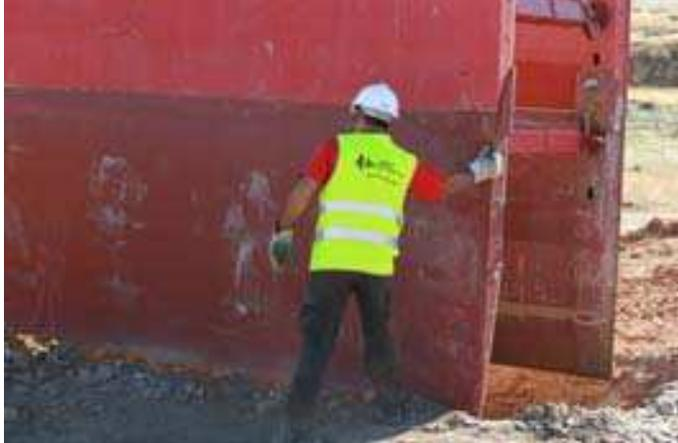
Si las dimensiones del módulo están muy ajustadas a las dimensiones de la excavación, se colocarán unos cascos de empuje en la parte superior de los paneles para empujarlos (no golpearlos) hasta que alcancen su posición definitiva. De todos modos, independientemente de las dimensiones del módulo completo, los paneles superiores serán del tipo reforzado (con una banda amarilla superior) para permitir el empuje.
