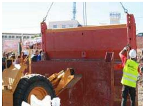
Inmediatamente se colocan los tornillos de unión (son los que tienen rosca) y se aprietan golpeándolos con la maza hasta que tengamos la seguridad de que se encuentran bien fijados.
