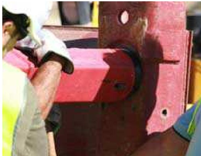
Posteriormente colocar la otra parte del codal y girar con el usillo para adaptarlo al ancho de zanja. Realizada esta operación, golpear las cuñas que llevan los codales hasta que se encuentren bien introducidas, teniendo la precaución de que la parte más ancha de las mismas quede en la parte superior.
