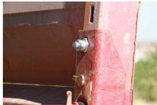
La siguiente operación a realizar es izar y colocar un nuevo panel, enfrentado con el ya montado encima de uno de los paneles de corte, realizando la misma operación. Hasta que los tornillos de unión y de gancho no estén correctamente fijados no podrán soltarse las eslingas.
