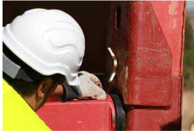
A continuación se colocan los tornillos de gancho teniendo la precaución de que el mismo quede sujeto con el nervio interior que llevan los paneles y que puede apreciarse mirando por la ranura que se encuentra por encima del agujero donde hemos colocado el tornillo de unión. Una vez enganchado, apretar fuertemente con golpes dados con la maza.
