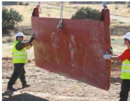
Seguidamente y manteniéndolo colgado, se le colocan dos barras auxiliares de montaje, cuyo extremo se introduce en uno de los orificios del panel y se asegura mediante una cuña, comprobando que el mismo se mantiene vertical una vez retirada la eslinga.
