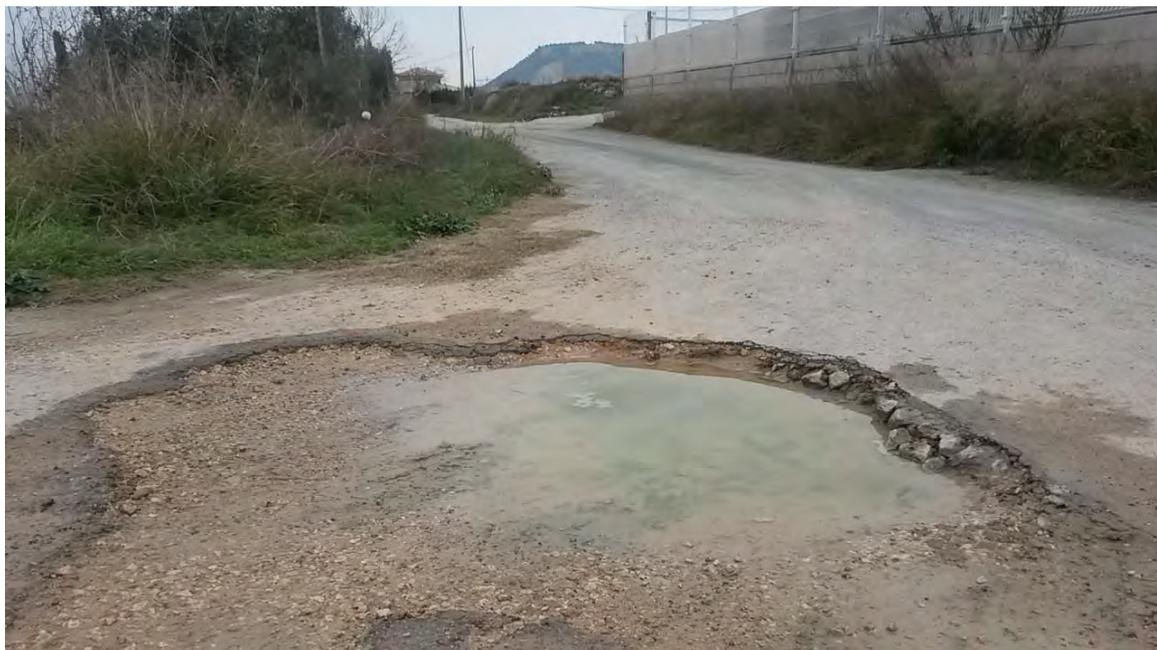
*Detalle del camino afectado en el SA-G043 que en el tramo inicial se encuentra asfaltado con doble tratamiento pero en muy mal estado, p.k. 1+960 a 2+550, correspondiendo este tramo a los primeros 30 m*
