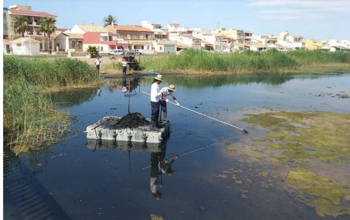
Imagen 3. Plataforma flotante de trabajo en aguas someras
