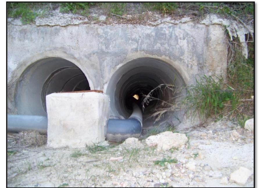
Imagen 7: Paso de colector existente por caño de cruce.
