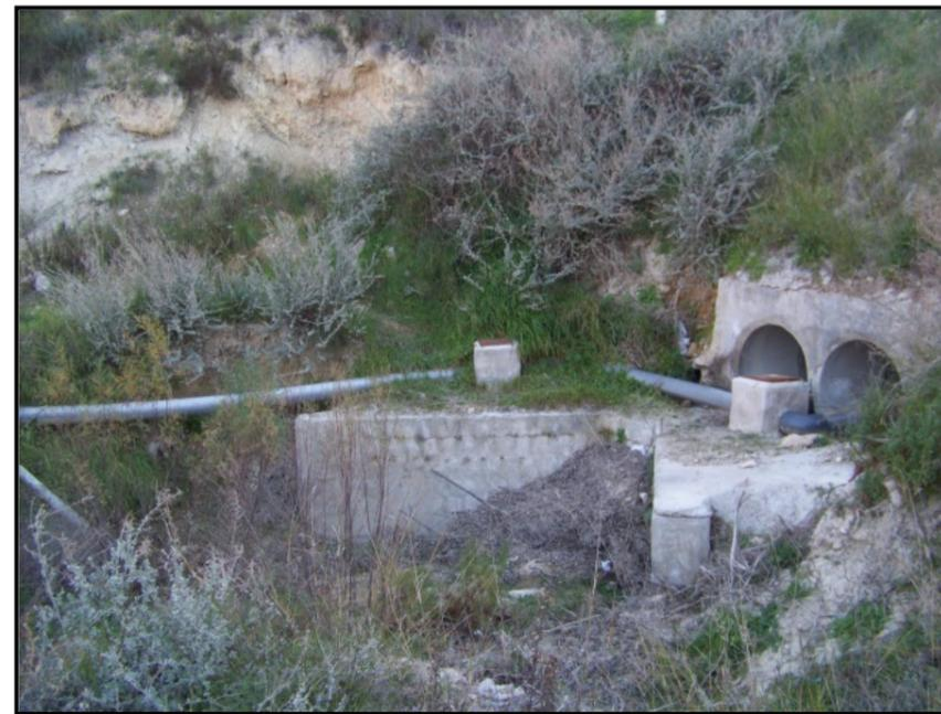
Imagen 6: Colector existente aguas arriba paso bajo calle Cedro. Caño de cruce.
