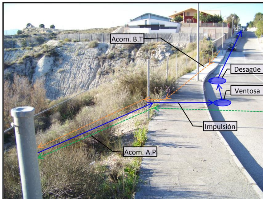
Imagen 8: Punto de salida de impulsión por cabeza de talud. Emplazamiento de ventosa, desagüe y acometidas.
