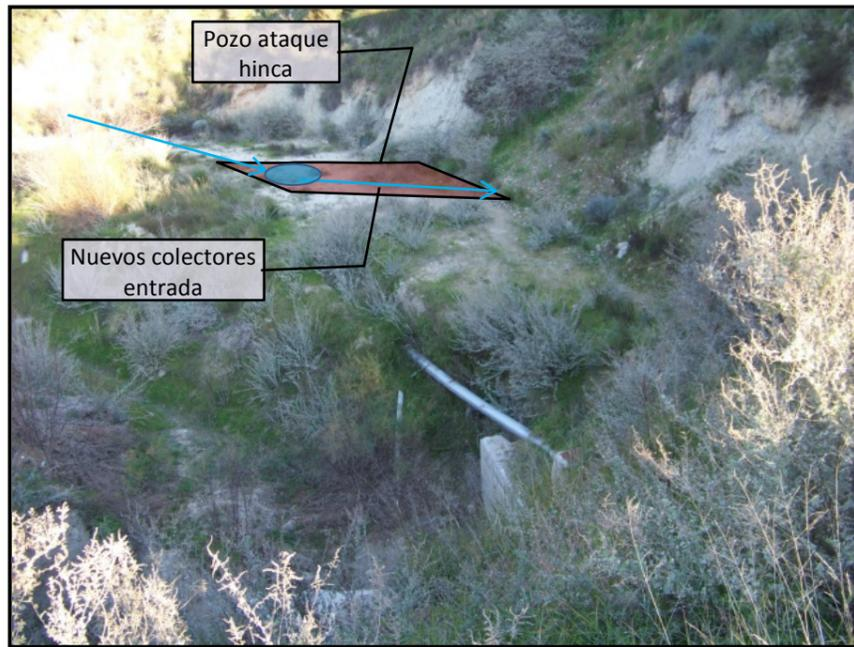
Imagen 5: Colector existente aguas arriba paso bajo calle Cedro. Emplazamiento hinca.
