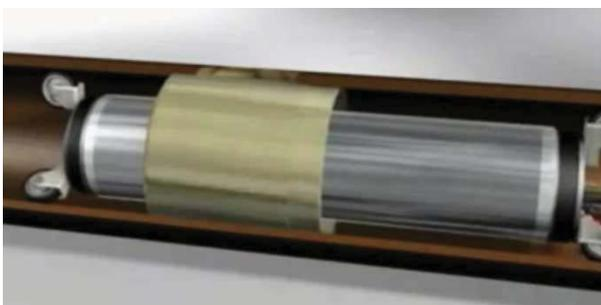
8. **Control de la manta instalada:** Un equipo de inspección TV comprueba la adaptación del manguito a la tubería original, la terminación de los bordes, la homogeneidad de la fibra y resina en toda su superficie y la ausencia de otros problemas visibles.
