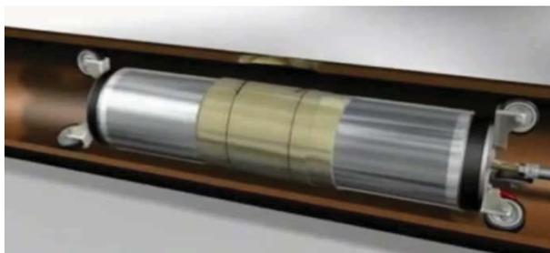
6. **Inflado del packer:** Se abre la llave de aire para hinchar el packer suavemente, mientras se controla el proceso mediante la cámara TV y manómetro. Una vez que el packer presione contra la pared de la tubería, se pueden soltar las cuerdas de arrastre.
