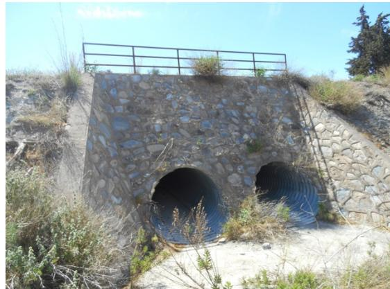
OBRA DE DRENAJE TRASNVERSAL. 2 TUB. ARCO Ø1600-1500
