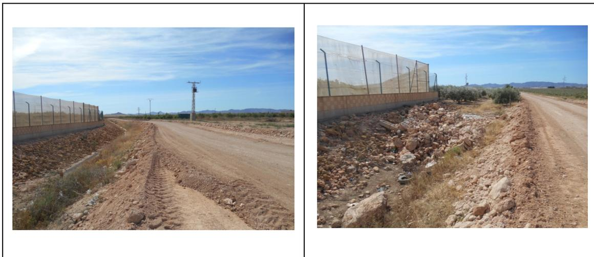
La finca adyacente a la traza del camino situada en el P.K. 1+012 cuenta con una rejilla de medidas 5 m x 0,3 m para la evacuación fuera de la finca de aguas de pluviales. Se propone para evitar erosiones en el camino la ejecución de un badén de 5 m de longitud realizado en hormigón
