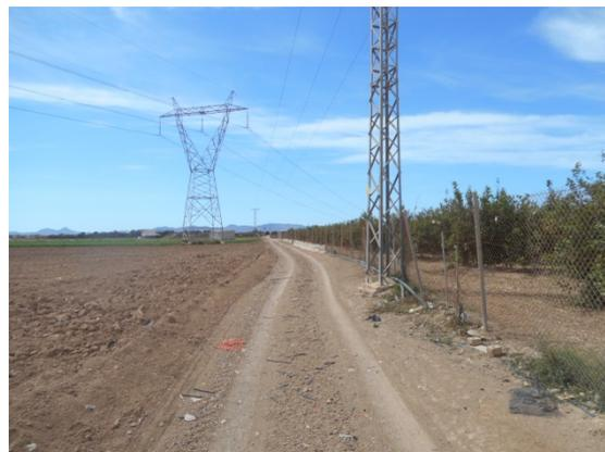
TRAMO EN TIERRA. EXISTENCIA DE APOYO DE MEDIA TENSIÓN. ANCHO 4.30 ml Y PASO LIBRE A LA ALTURA DEL POSTE 3.00 ml
