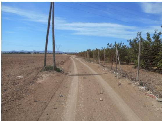
TRAMO EN TIERRA. EXISTENCIA DE 3 POSTES DE MADERA DE BAJA TENSIÓN. ANCHO 6.00 ml Y PASO LIBRE A LA ALTURA DEL POSTE 5.20 ml
