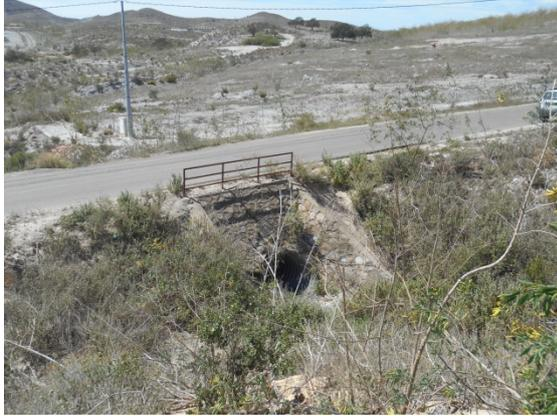
OBRA DE DRENAJE TRASVERSAL. 2 TUB. ARCO Ø1600-1500
