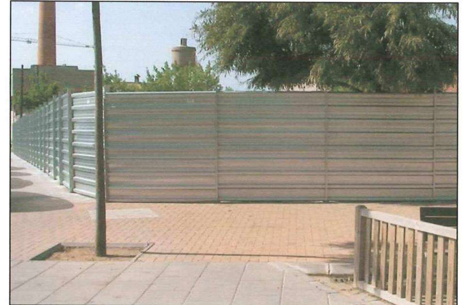
DETALLE DEL VALLADO PERIMETRAL: Valla opaca de 2m de altura de chapa gredada
