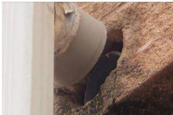
**Fotografía 4:** imagen parcial de la desconexión de una bajante al sumidero de pluviales (salida horizontal exterior).
