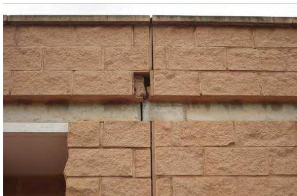
**Fotografía 3:** imagen de la junta de dilatación abierta donde se aprecia el desprendimiento de una pieza de bloque correspondiente al antepecho de cubierta.
