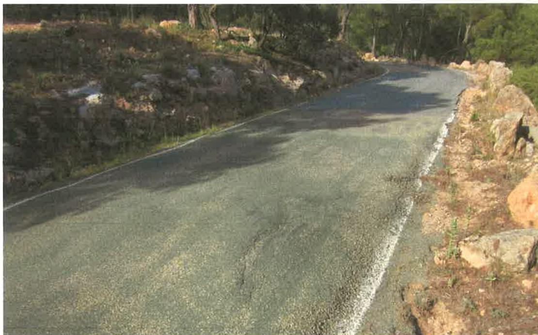
**Ilustración 13: Deformaciones superficiales de gran magnitud y roturas de borde de calzada.**
