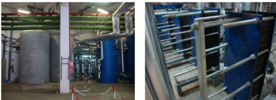
**Figura 15 Depósitos de ACS e intercambiadores de calor**
