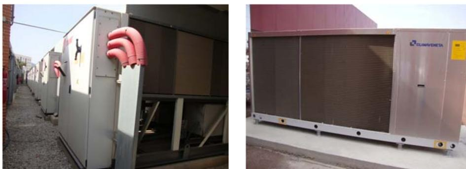
**Figura 19 Plantas enfriadoras del sistema centralizado y enfriadora independiente**
