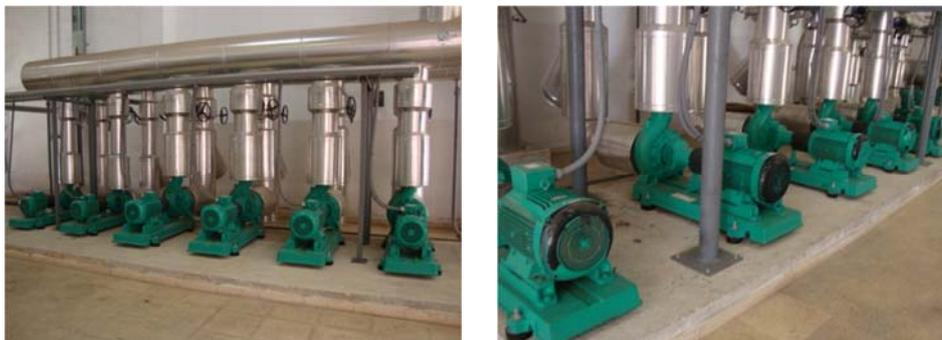
**Figura 21 Bombas del circuito de agua caliente y agua fría de la Central Térmica**
