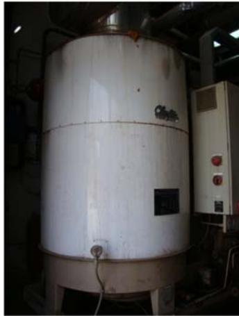
**Figura 20 Generador de Vapor**
