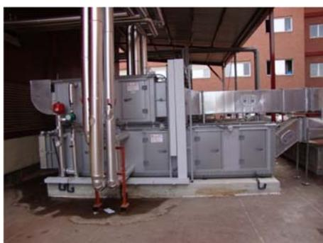
**Figura 26 Climatizador con recuperación de calor**
