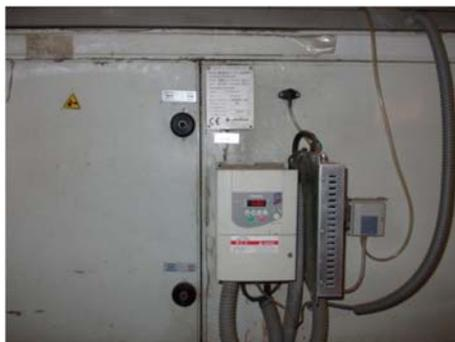
**Figura 25 Climatizador con variador de velocidad**
