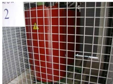
**Figura 10 Transformadores del CT Nº2 y del CT Nº5, respectivamente.**
