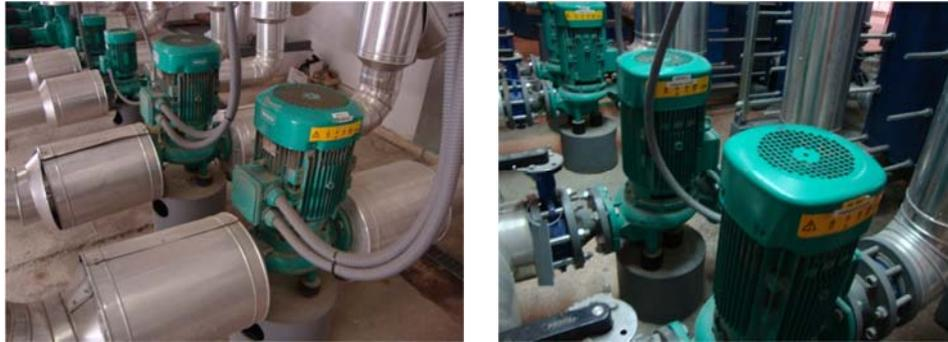
**Figura 22 Bombas del circuito primario de ACS y del circuito de ACS del solar térmico**
