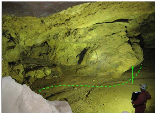
Sostenimiento de bloques inestables en hastial N (dos bloques) mediante bulonado sistemático. Para las operaciones de bulonado, se colocará una estructura metálica de sostenimiento de los bloques afectados. También se bulonarán dos grandes bloques que presentan
