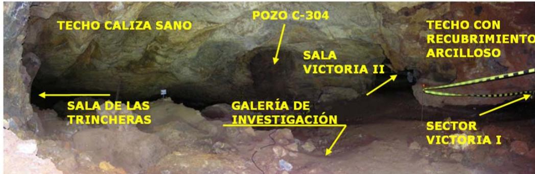
En la zona E, existe un pozo vertical (**pozo C-304**) que comunica con el exterior. El pozo, de 18m de altura, está excavado en sección circular de 2m de diámetro. Las paredes son de roca desnuda, y se encuentran en unas condiciones aceptables de estabilidad. De los 18m de pozo, los 5m superiores atraviesan un lecho de depósitos coluvionares, mientras que los 13m restantes están excavados en el macizo de caliza que conforma la roca encajante del yacimiento.
