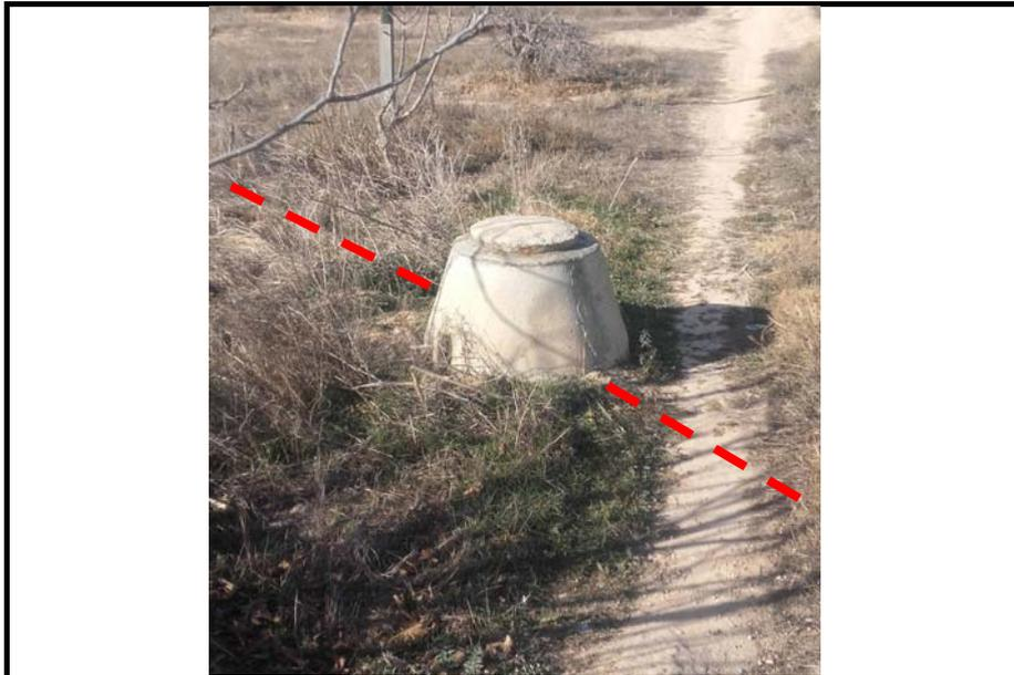
**FOTOGRAFÍA Nº 23:** Pozo del antiguo colector situado al final de ramal 6
