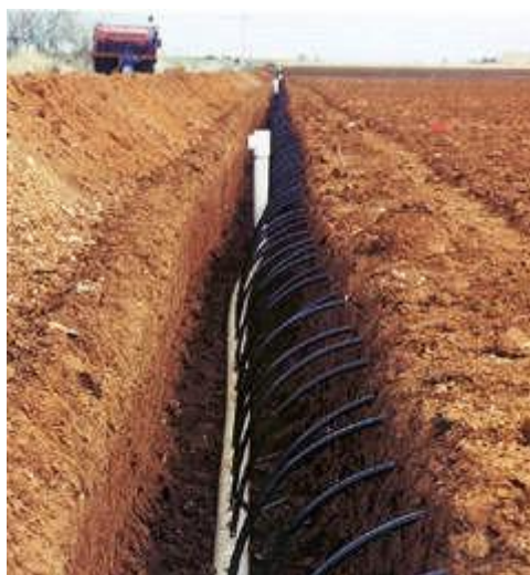
Foto nº 2. Zanjas para el enterrado de la instalación de riego.
