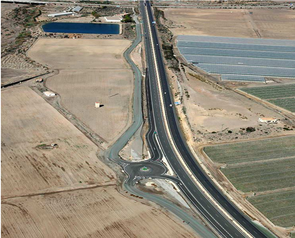
ORDENACIÓN DE ACCESOS AUTOVÍA LORCA-AGUILAS 2º FASE
