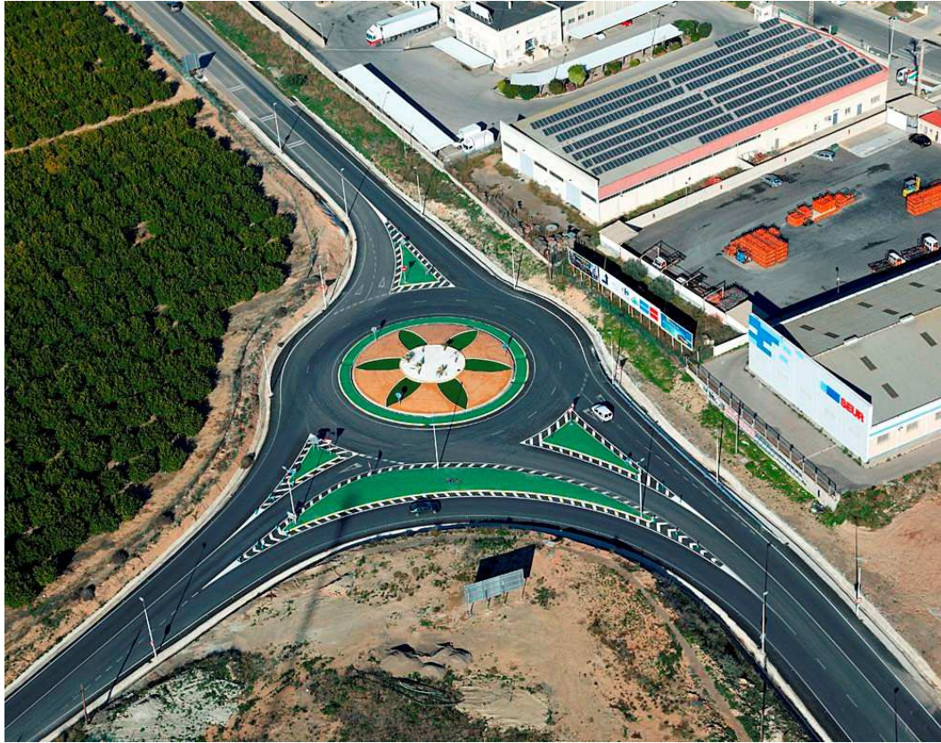
CONSTRUCCIÓN GLORIETAS EN TRAVESÍA RM-F35 CABEZO BEAZA, CARTAGENA
