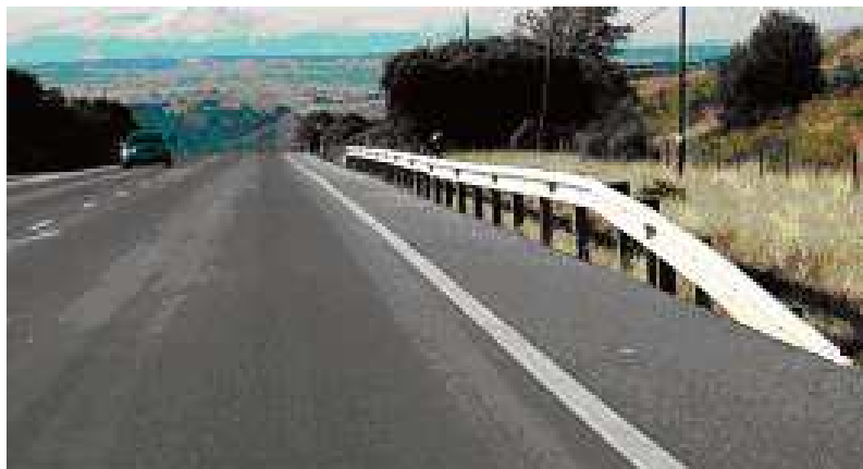
Protección de obstáculos con barrera metálica
