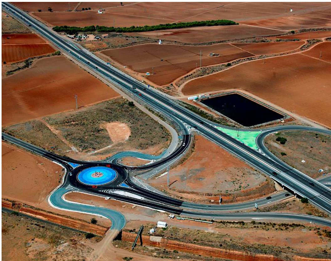
REMDELACIÓN ENLACES AUTOVÍA DE LA MANGA RM-12
