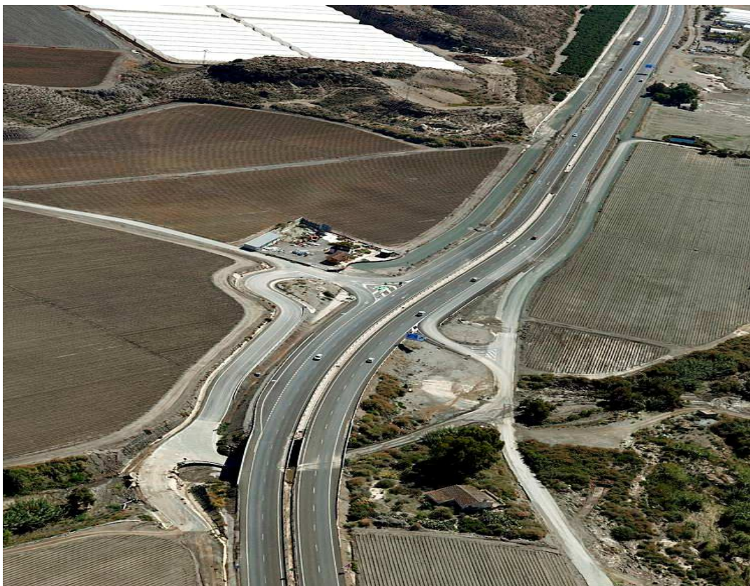
ORDENACIÓN DE ACCESOS AUTOVÍA LORCA-AGUILAS 2º FASE
