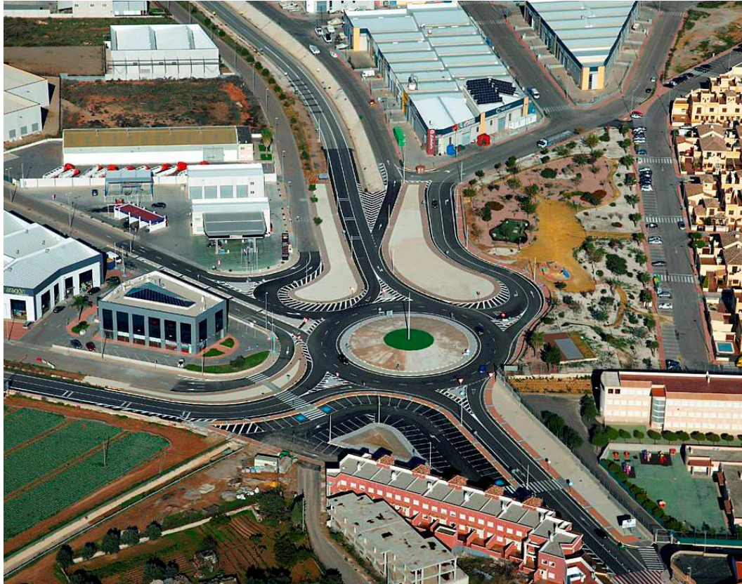
CONSTRUCCIÓN DE GLORIETA EN INTERSECCIÓN RM-F40 Y RM-F41 LA UNIÓN
