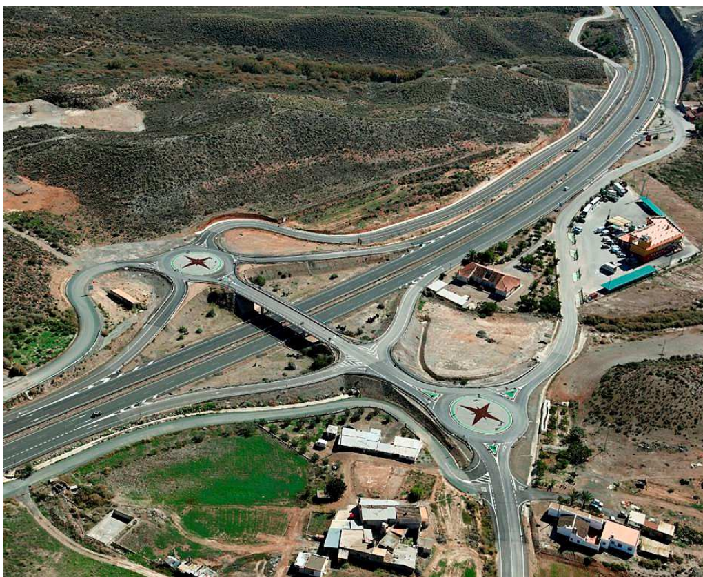
ORDENACIÓN DE ACCESOS AUTOVÍA LORCA-AGUILAS 2º FASE
