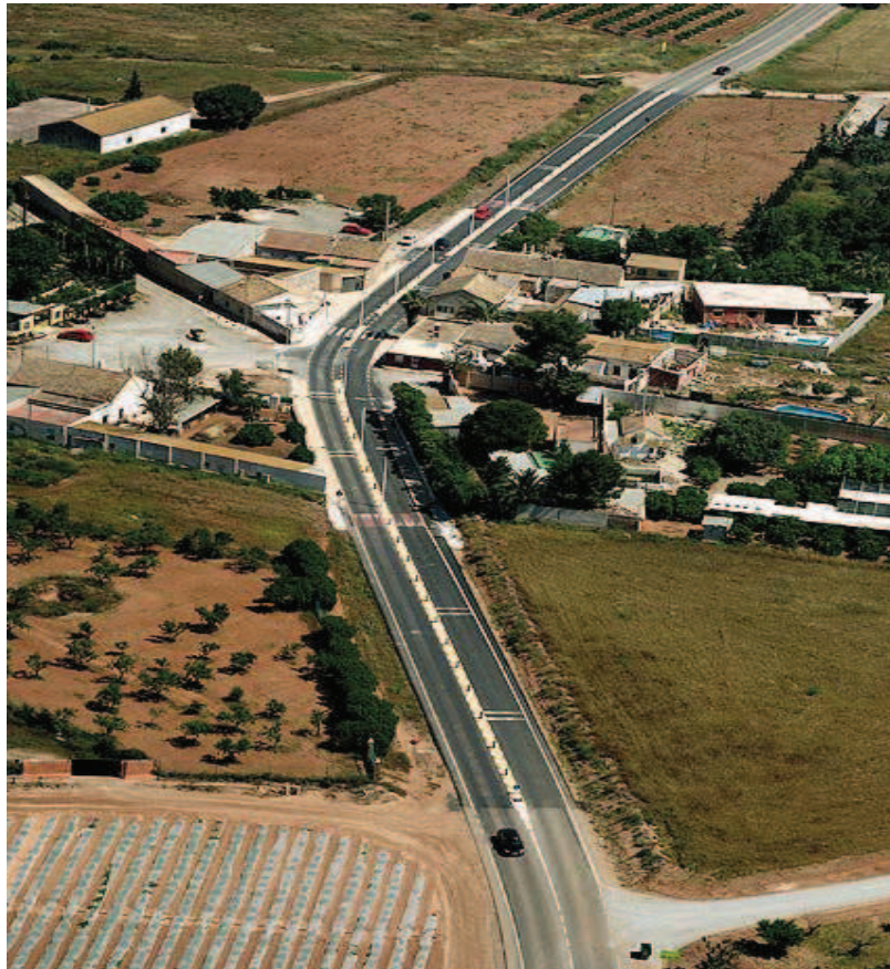
MEJORAS DE SEGURIDAD VIAL EN LA TRAVESÍA DE MOLINO DERRIBAO CTRA RM-605.
