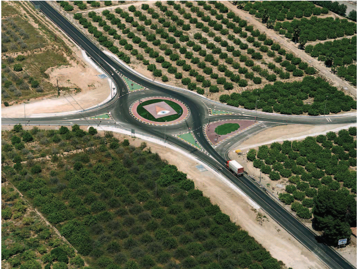
CONSTRUCCIÓN DE GLORIETA EN CTRA. RM-414 P.K. 2,5. SANTOMERA
