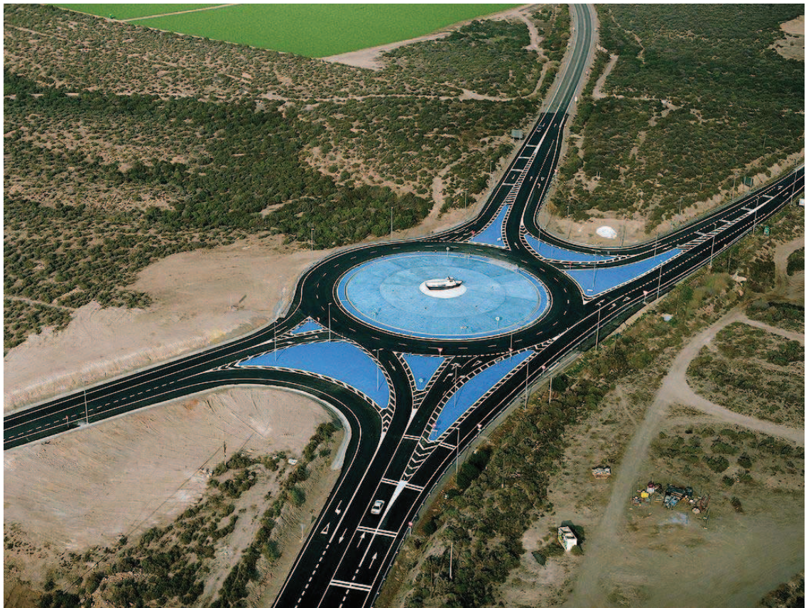
CONSTRUCCIÓN DE GLORIETA EN CTRA. RM-333 Y RM D18 EN AGUILAS
