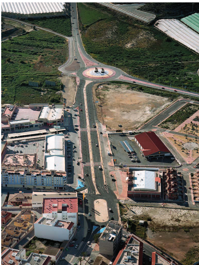
DUPLICACION DE CALZADA TRAVESIA RM-332 PUERTO DE MAZARRON
