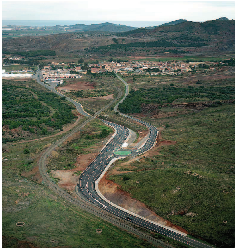
ACONDICIONAMIENTO INTERSECCIÓN RM-F43 CON RM-F42. EL LLANO DEL BEAL.
