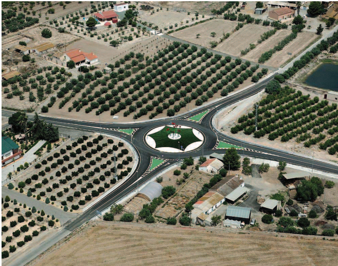
CONSTRUCCIÓN DE GLORIETA EN RM-D16 CON CAMINO DEL ARMAO. P LUMBRERAS.
