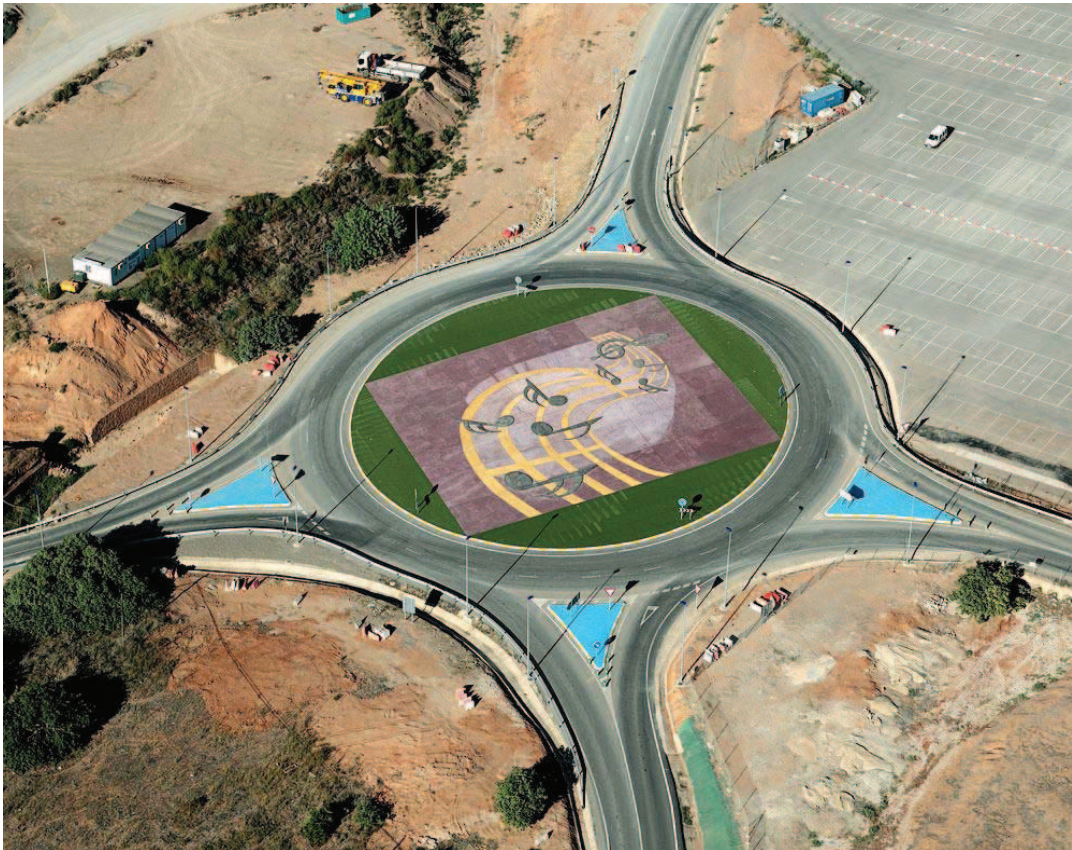
CONSTRUCCIÓN DE GLORIETA EN INTERSECCIÓN DE CTRAS. RM-320 Y RM-322. ESCOMBRERAS
