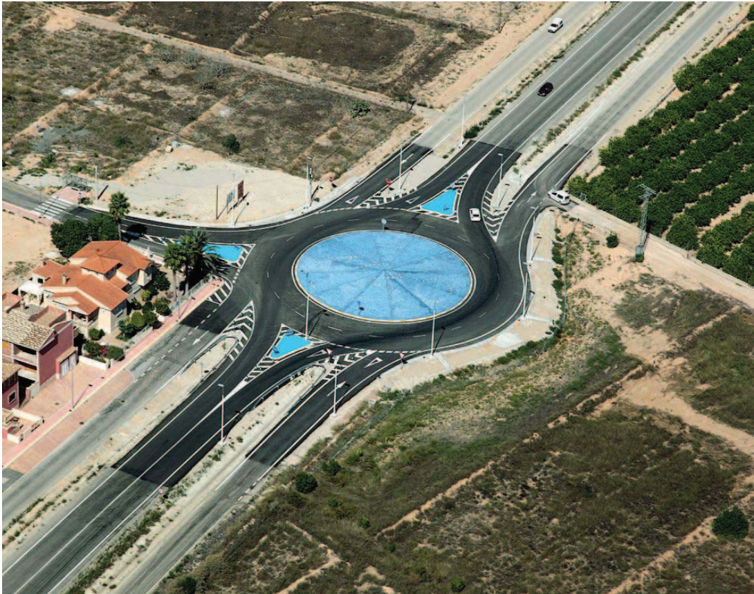
CONSTRUCCIÓN DE GLORIETAS EN RM -414 ACCESOS A LA GINETA Y EL RELOJ.
