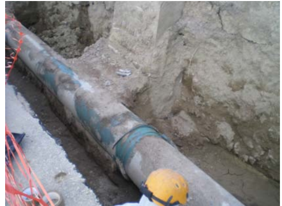
Aglutinante aplicado al fibrocemento
