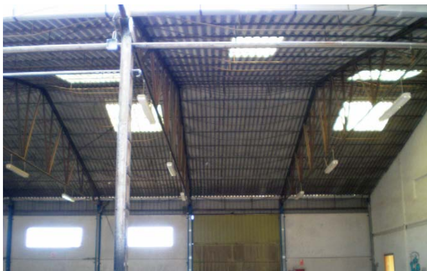
Placas de fibrocemento en buen estado
