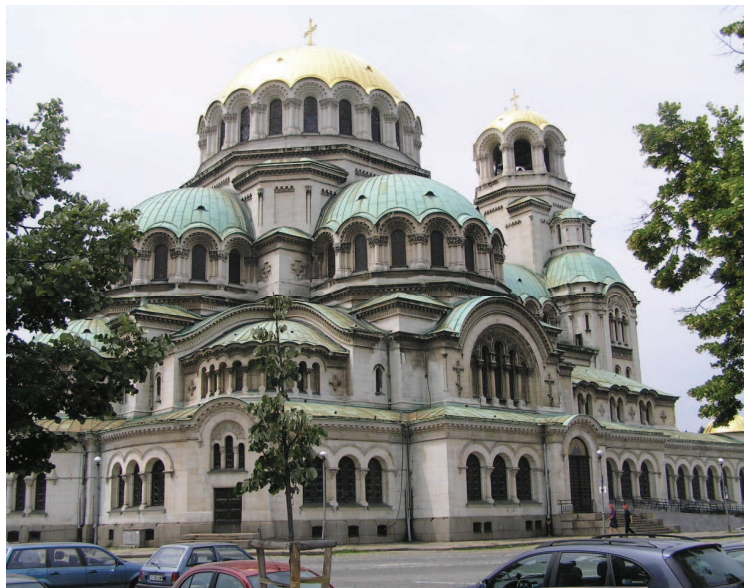
Fotografía 7.3.d. La catedral ortodoxa de Sofía con sus cubiertas recubiertas de productos de corrosión del cobre con su característico tono turquesa.
