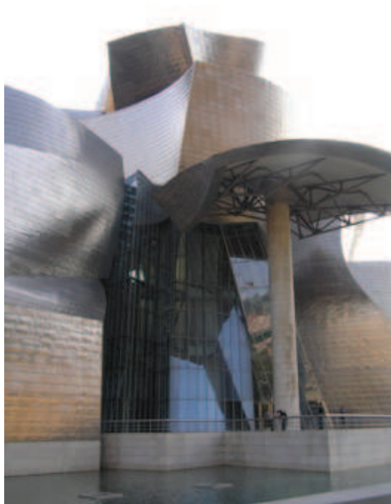
Figura 3.6.a. Planchas de titanio en la fachada del museo Guggenheim de Bilbao
