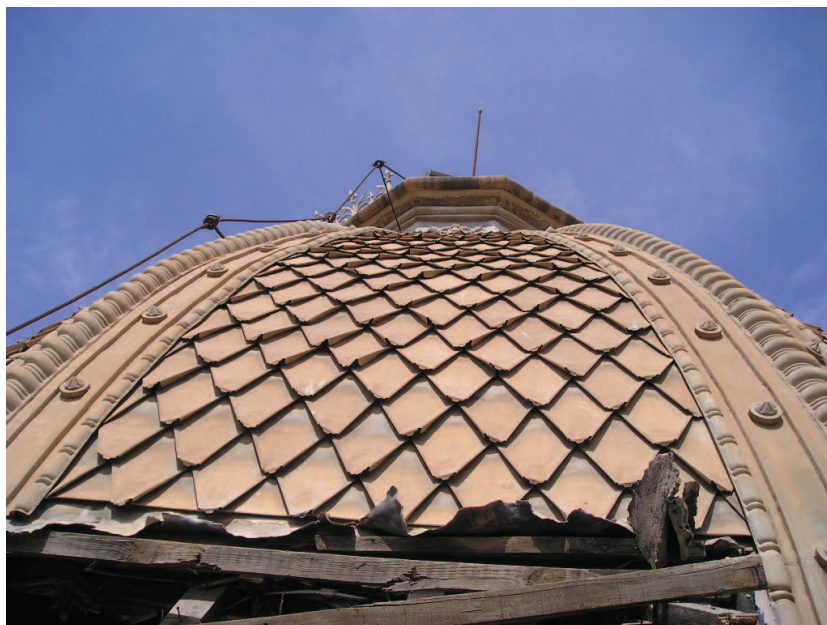
Figura 3.4.b Cúpula recubierta de planchas de cinc.
