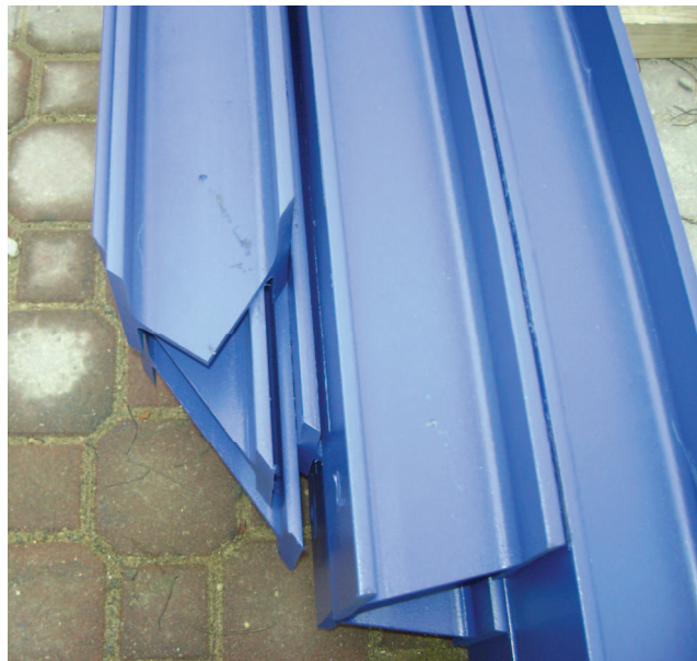
Figura 10.6.c Perfiles estructurales preparados para su montaje
