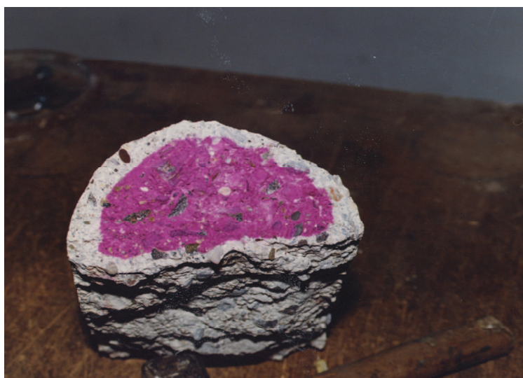
Figura 5.1.a Capa carbonatada en un fragmento de hormigón
