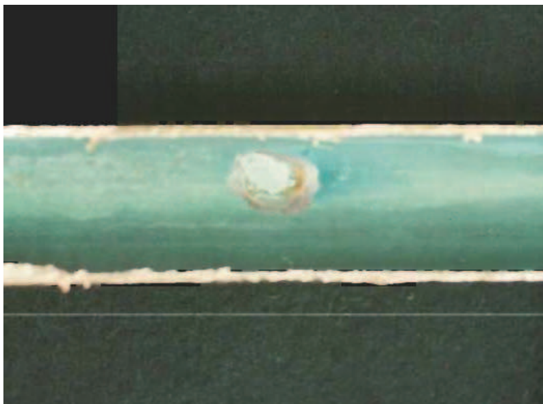
Ejemplo de referencia: Tubo de cobre con una picadura por el interior
