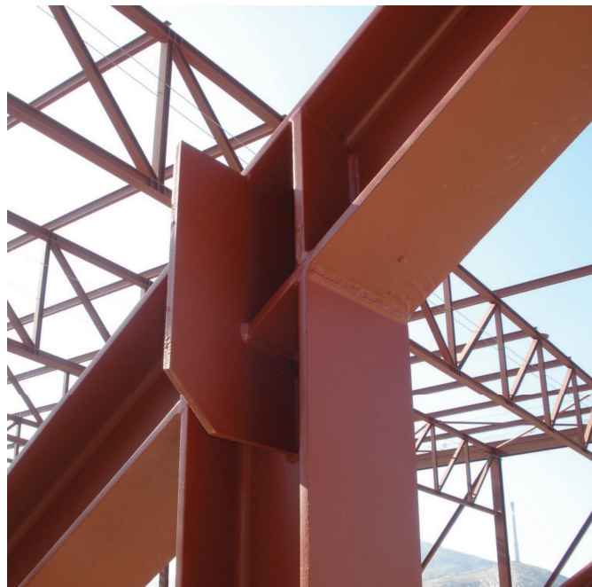
Fotografía 6.1. Nudo de estructura metálica con protección mediante pintura
