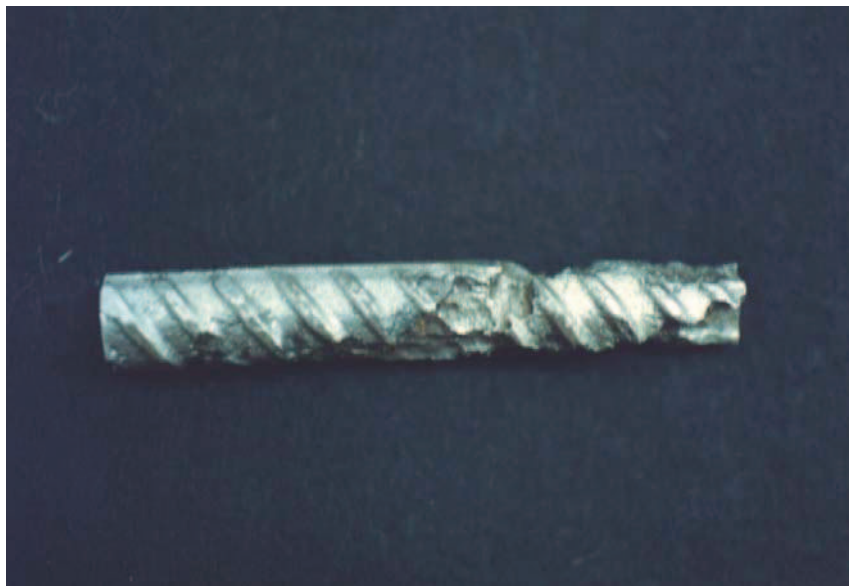
Figura 2.3.b Formación de picaduras en una armadura. En algunos tramos la sección se había reducido a la mitad.
