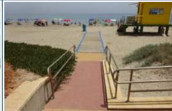
3 Rampa de acceso y pasarela
