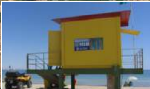
1.2 Puesto de vigilancia
