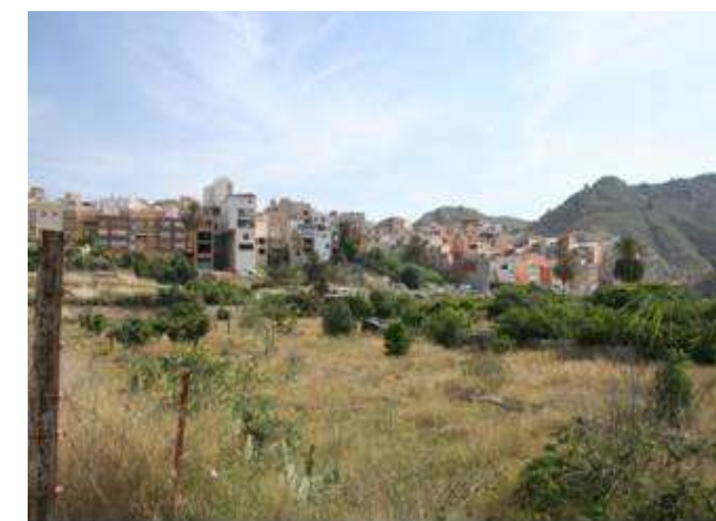
Edificaciones en el ámbito de estudio
