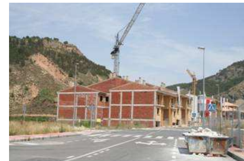
Construcción de viviendas.
