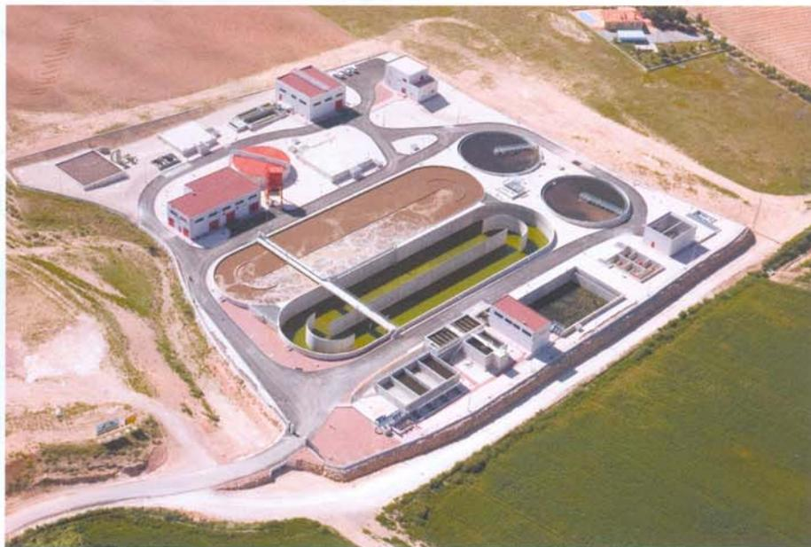
EN UNA EDAR EXISTEN TRES LÍNEAS DIFERENTES DE PROCESO: **LA LÍNEA DE AGUA, LA LÍNEA DE FANGOS Y LA LÍNEA DE AIRE** (DESODORIZACIÓN DEL AIRE CONTAMINADO). LA LÍNEA DE AGUA, A SU VEZ, SE PUEDE SEPARAR EN DOS: TRATAMIENTO BIOLÓGICO Y TRATAMIENTO TERCIARIO.
