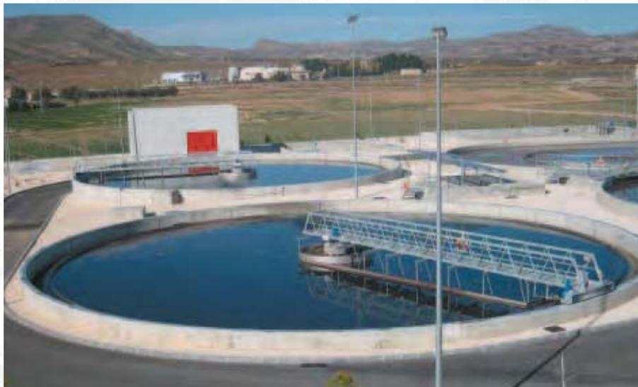
En una E.D.A.R. existen dos tipos de decantadores: los primarios y los secundarios, que se sitúan antes de los reactores biológicos (los primarios) y después de los reactores (secundarios, los más usuales). Habitualmente son depósitos abiertos circulares donde el agua queda en reposo con el fin de facilitar la separación física del agua depurada y poseen un puente móvil con movimiento radial.
