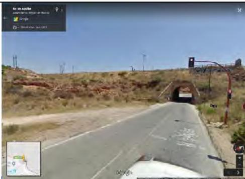
Imagen extraída de Google Maps, donde se aprecia el túnel de la infraestructura ferroviaria, que sirve tanto de drenaje para la Rambla del Moro García, cuyo cauce se observa a la izquierda, como para el paso de los vehículos bajo vía de la carretera RM-D17.
