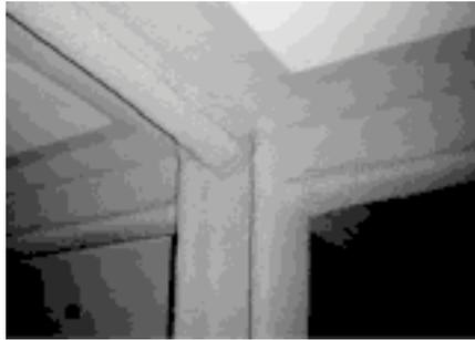
Proyectado de fibras (flocage) como revestimiento ignífugo en estructura metálica.
