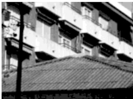
Placas de fibrocemento en cubierta.
