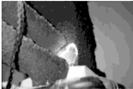
Proyectado de mortero y fibras como revestimiento ignífugo en pilar y jácena metálicas.
