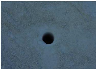
Lo más habitual es el anclaje de apoyos metálicos en un pequeño barreno perforado en la roca (agujero de 30 -45 cm. de profundidad y pequeño diámetro, entre 38 – 65 mm.), sin ningún tipo de tortillería, siendo de fácil instalación a la vez que no se ve dañada la piedra. (No se pueden dejar tornillos ya que romperían la maquina cortabloques)
