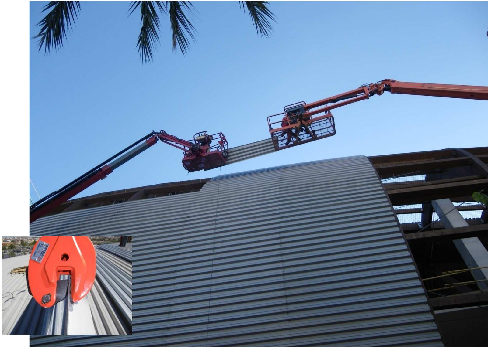
Accesorio de elevación específico
