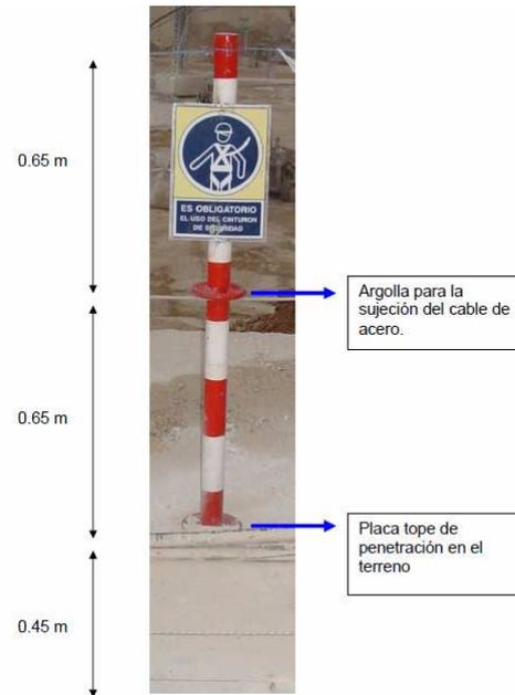
Anclaje metálico instalado en varias explotaciones mineras, anclaje no certificado por ningún fabricante pero de muy buena resistencia y calidad. (1,75 m.)
