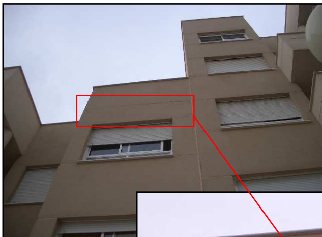
Figura 19. Fachada de ladrillo revestida con mortero monocapa. Avenida de Europa. Murcia
