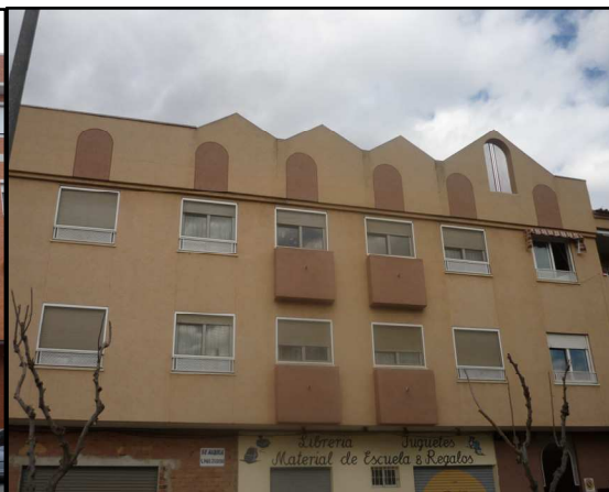
Figura 7. Fachada con revestimiento monocapa. Zarandona. Murcia
