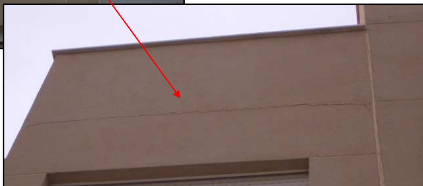
Figura 19. Fachada de ladrillo revestida con mortero monocapa. Avenida de Europa. Murcia
