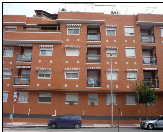
Figura 6. Fachada de ladrillo cara vista. La Flota. Murcia
