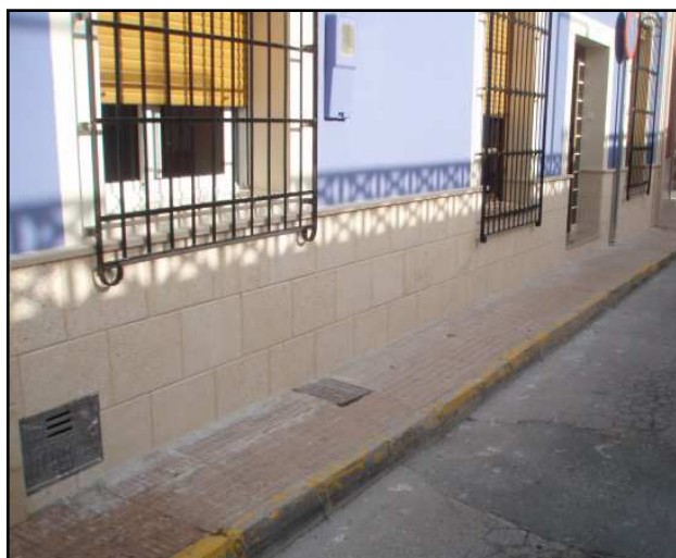
Figura 17. Fachada de vivienda unifamiliar. Santomera. Murcia
