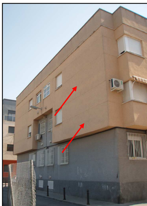
Figura 15. Juntas propia de dilatación del revestimiento exterior. Fachada de ladrillo revestido de monocapa en edificio plurifamiliar. Barrio del Progreso. Murcia
