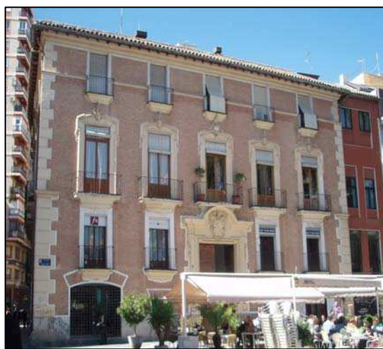
Figura 5. Fachada de ladrillo cara vista. Plaza del Romea. Murcia
