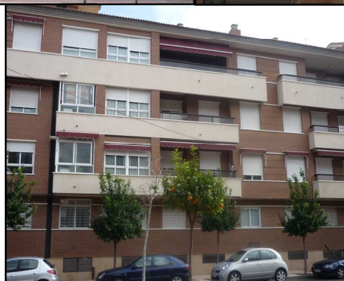
Figura 6. Fachada de ladrillo cara vista. La Flota. Murcia
