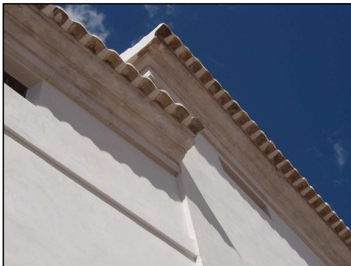
Figura 27. Ejemplo de cornisa de cubierta.
