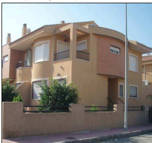
Figura 4. Fachada combinada de ladrillo cara vista y monocapa. Santomera. Murcia
