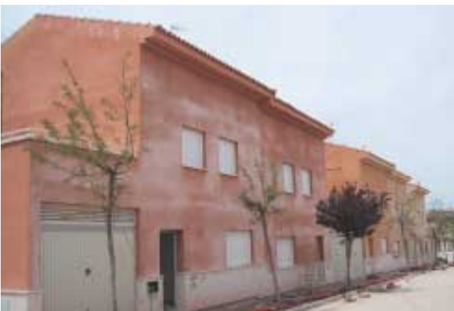
EFLORESCENCIAS BLANCAS: Aparición de manchas blanquecinas sobre la superficie del revestimiento
