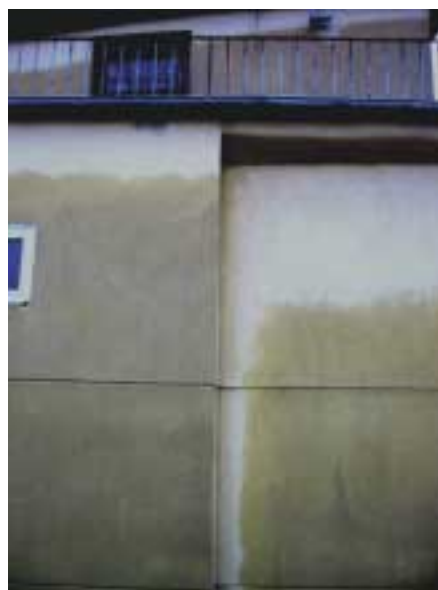
ESPECTROS EN JUNTAS DE ALBAÑILERÍA: Manchas que pueden aparecer en fachada tras una lluvia intensa.
