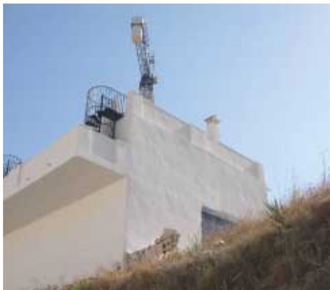
DIFERENCIA DE COLOR: Diferencia apreciable de color entre los diferentes paños de la fachada (limitados por despieces) o bien dentro de un mismo paño. La textura es similar en todo el paño.
