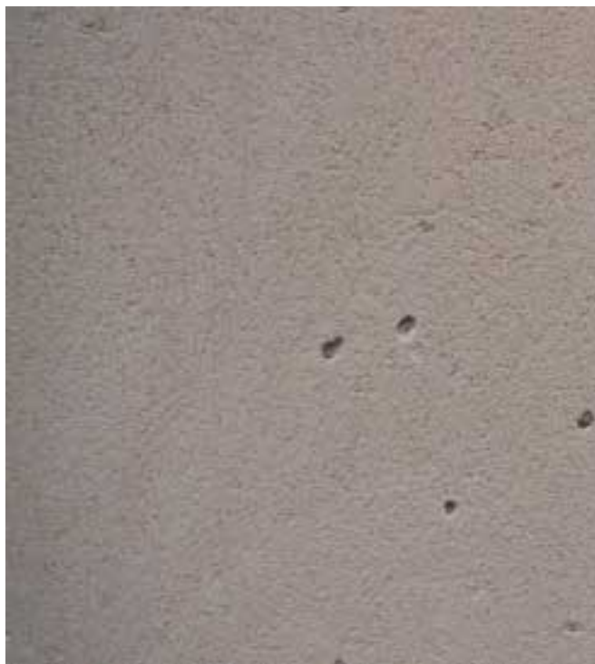
COQUERAS O ABUJEROS: Pueden aparecer una vez hemos realizado el acabado final del revestimiento raspado.
