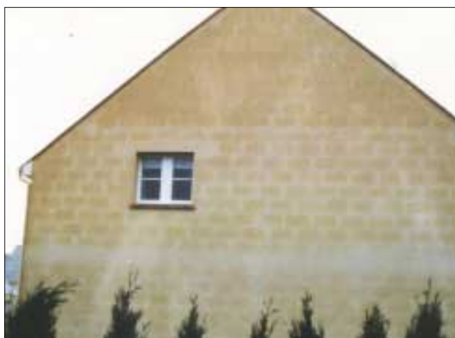
ESPECTROS EN JUNTAS DE ALBAÑILERÍA: Manchas que pueden aparecer en fachada tras una lluvia intensa.
