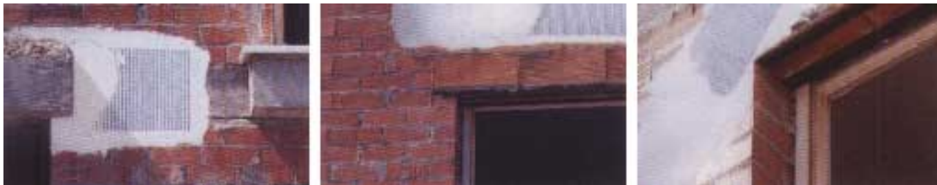
Colocación de la malla en los puntos singulares del edificio
