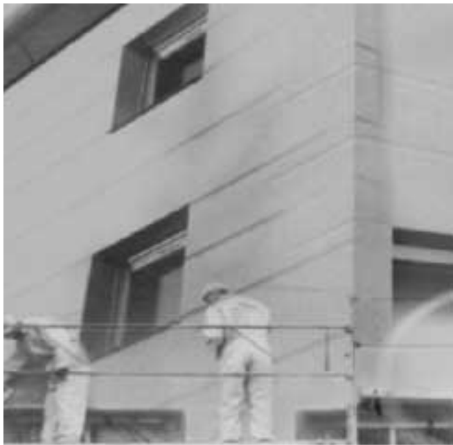
Distancia vertical entre juntas horizontales: 2,50 m. Entre juntas verticales: 7 m.
