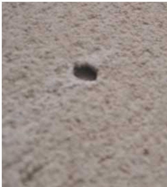
COQUERAS O ABUJEROS: Pueden aparecer una vez hemos realizado el acabado final del revestimiento raspado.
