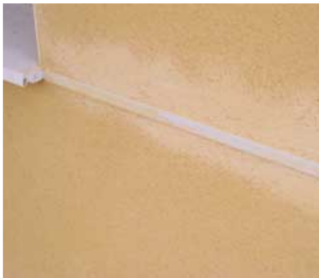
DIFERENCIA DE COLOR: Diferencia apreciable de color entre los diferentes paños de la fachada (limitados por despieces) o bien dentro de un mismo paño. La textura es similar en todo el paño.
