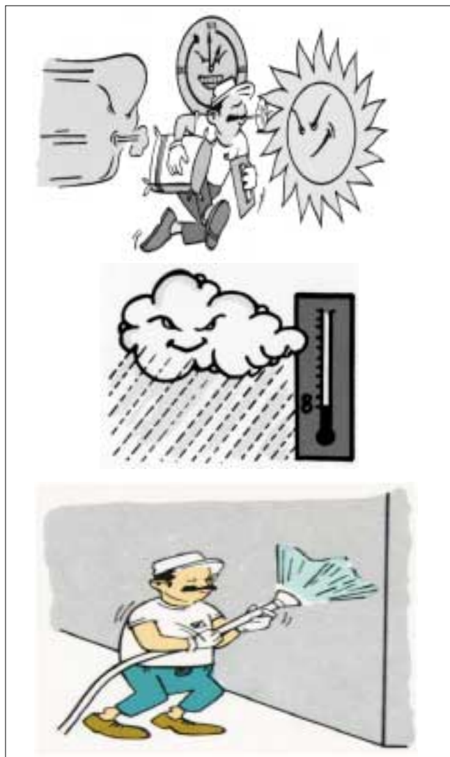
En tiempo caluroso y con viento seco, debe realizarse una humidificación del revestimiento 24 horas después de su aplicación
