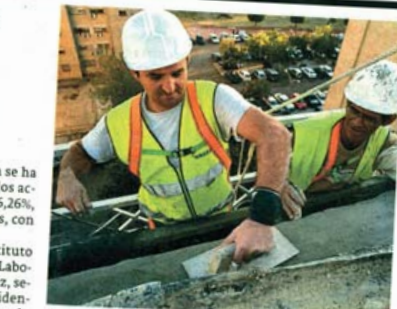
Dos trabajadores de una cooperativa de construcción, en la rehabilitación de un bloque de pisos. C. ORTEGA
