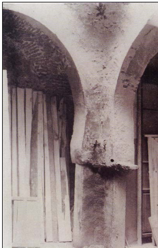
Fig.9. Detalle del arranque de los arcos
