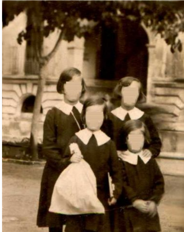
Fig.5. Detalle del zócalo almohadillado, hacia 1932 (AFNC)
