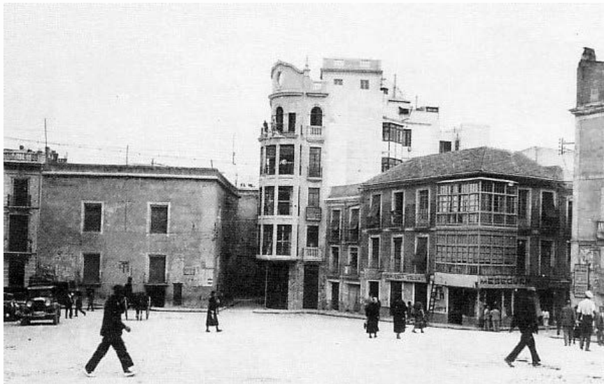
Fig. 11. Vista de la casa hacia 1931
