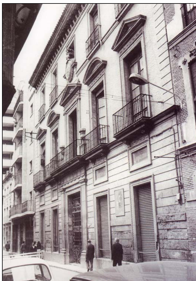
Fig. 4. Fotografía de la fachada poco antes de su derribo
