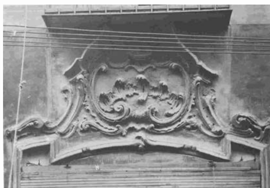
Fig.4. Detalle de rocalla de su fachada principal.
