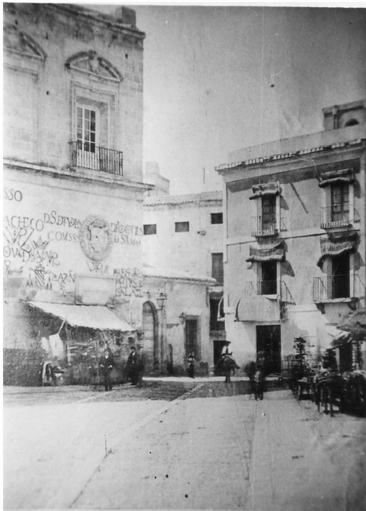
Fig. 3. Detalle parcial de la fachada
