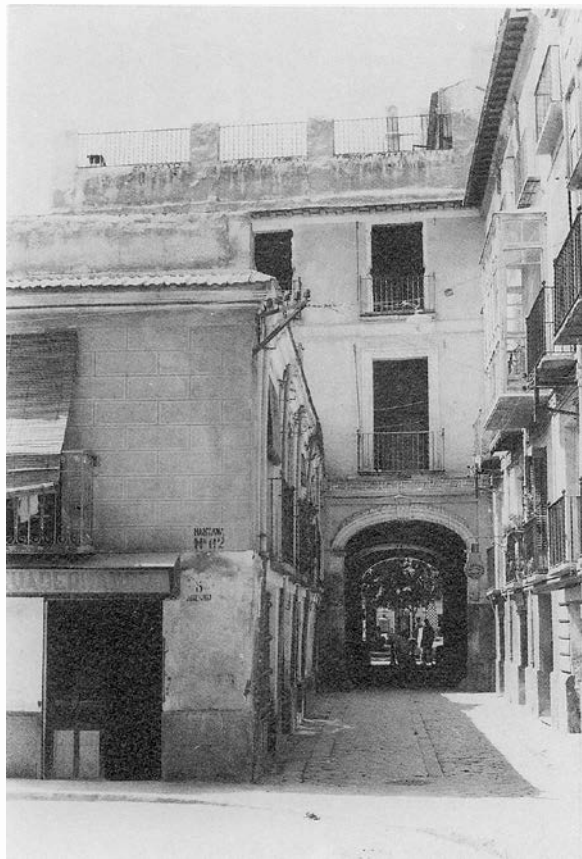
Fig.7. Detalle fachada posterior
