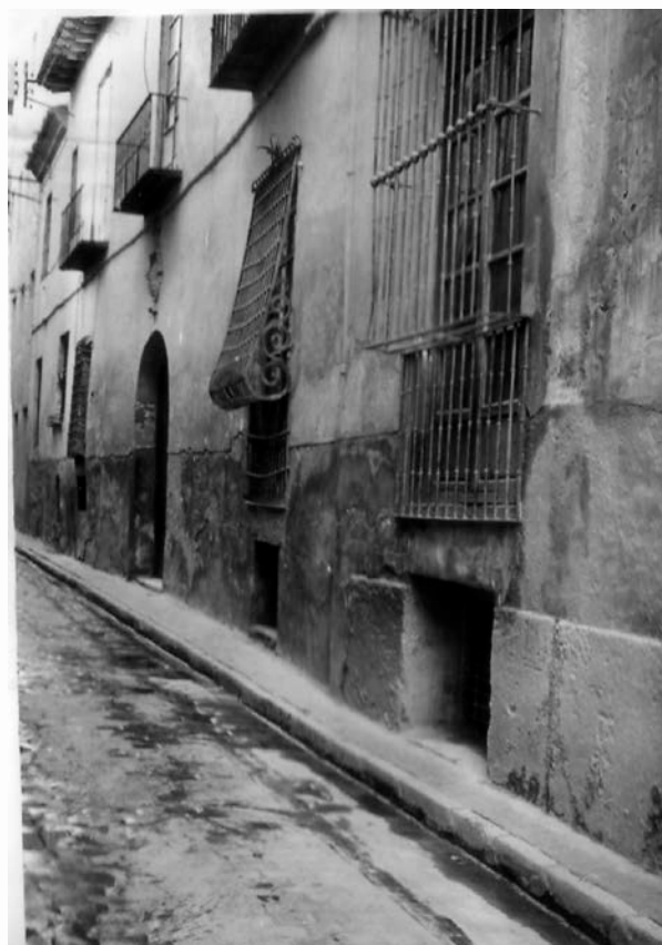
Fig. 4. Fachada principal a la calle del Porcel
