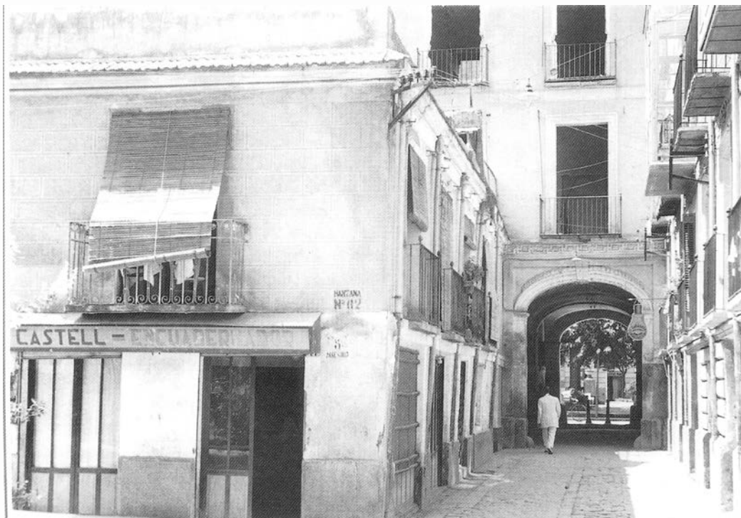
Fig.8, Detalle fachada posterior que daba al callejón de los Gatos
