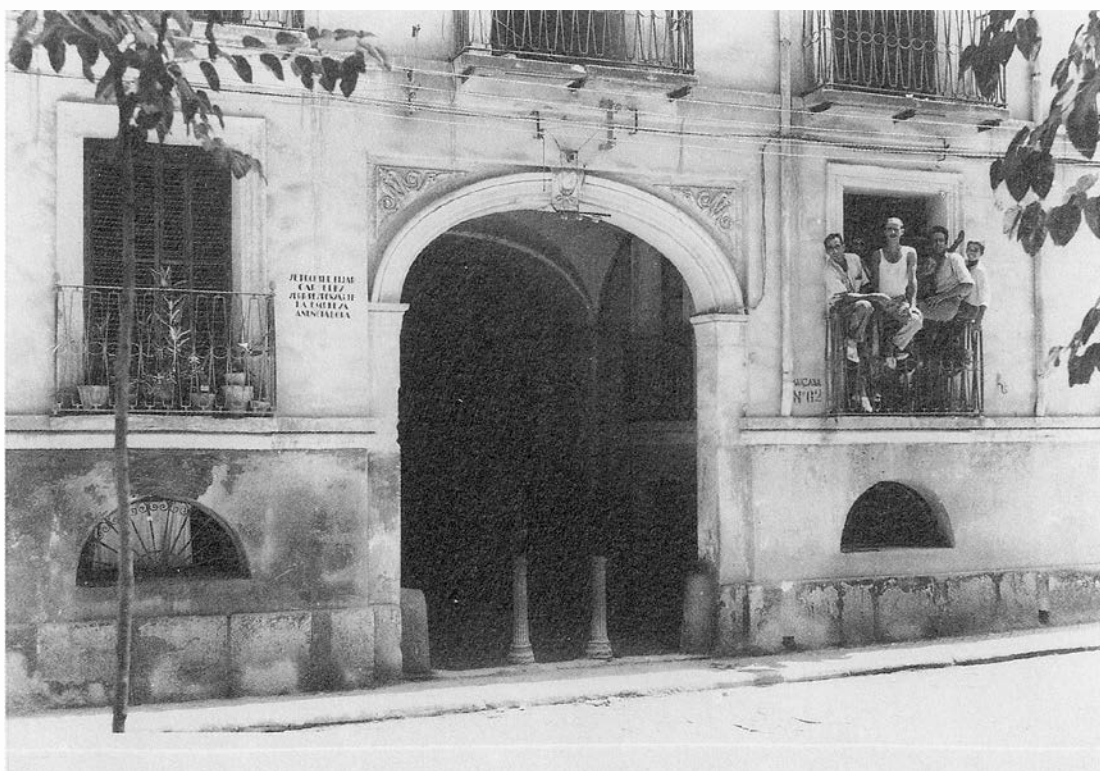
Fig.4. Fachada principal a la plaza de Santa Isabel
