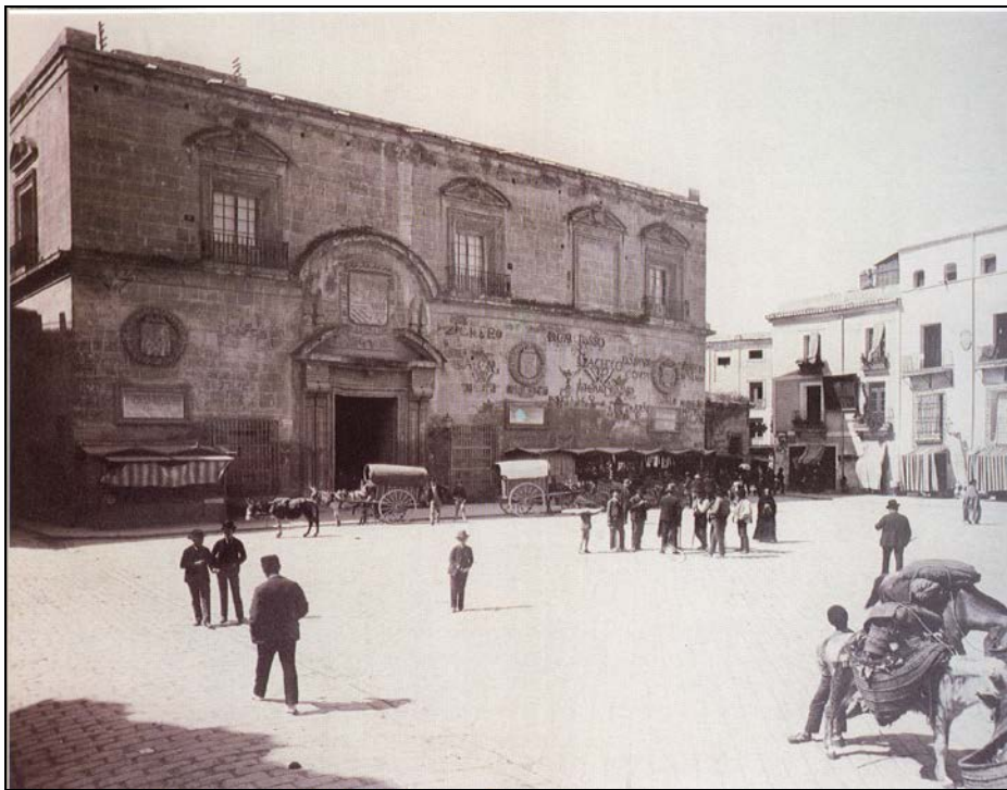
Fig.3. Fotografía de la fachada Norte
