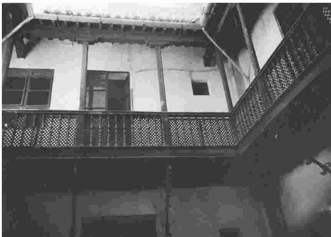
Fig.11. Detalle del segundo patio y de su galería
