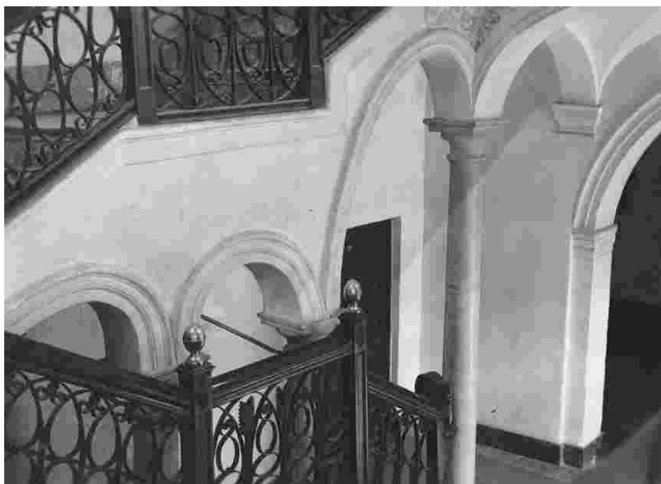
Fig.8. Detalle de la escalera
