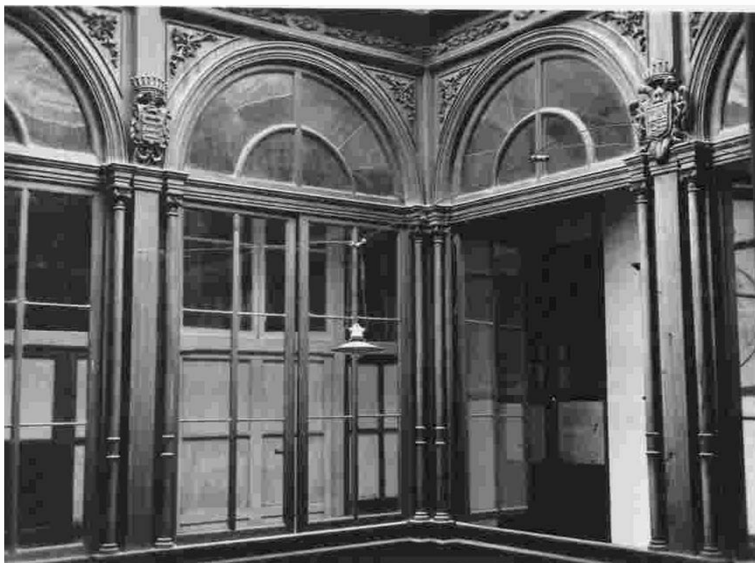
Fig.10. Detalle de la galería cerrada del patio principal, de estilo neoclásico
