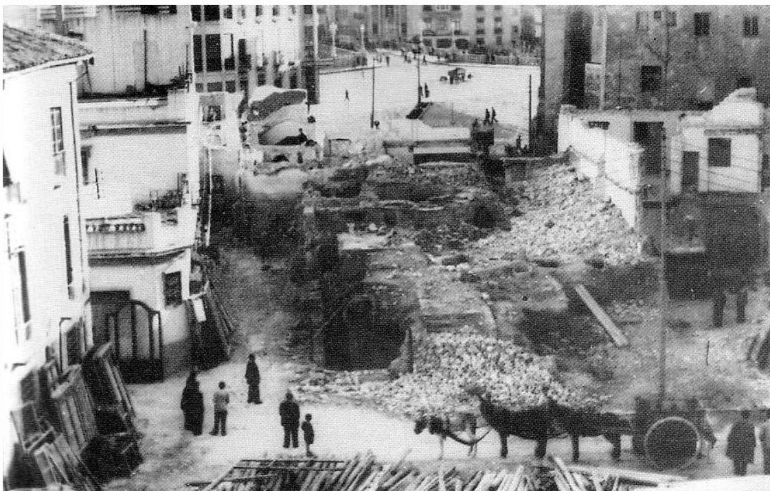
Fig.10. Derribo de los baños, 1953
