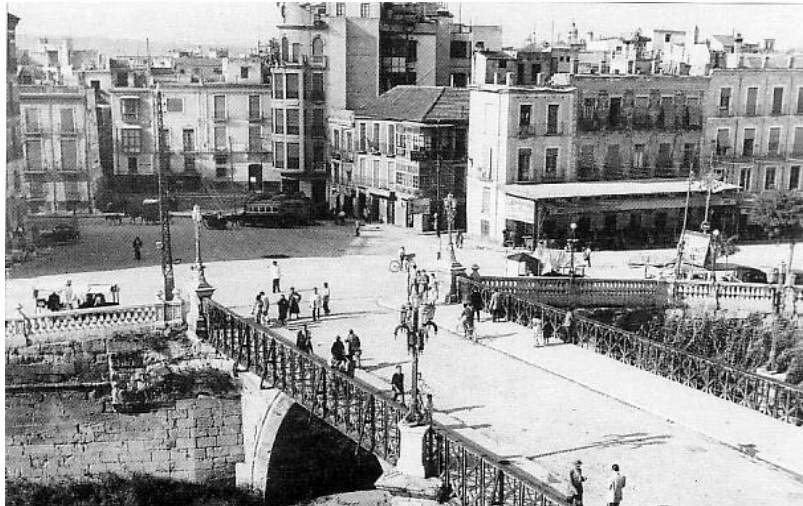
Fig.13. Solar dejado por el derribo de la Casa de la Cruz
