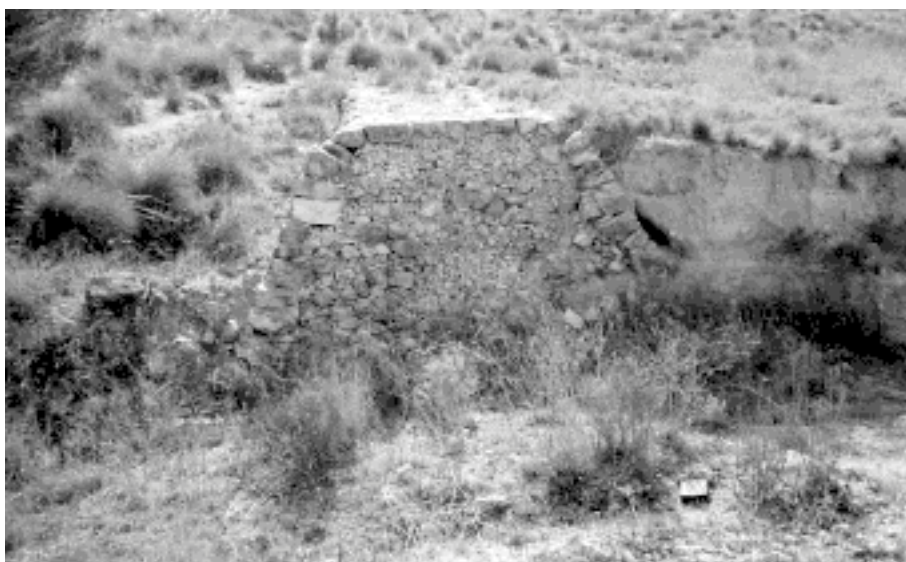
Foto 4.2. Presa de derivación en el barranco del Aljuzarejo (Jumilla).
