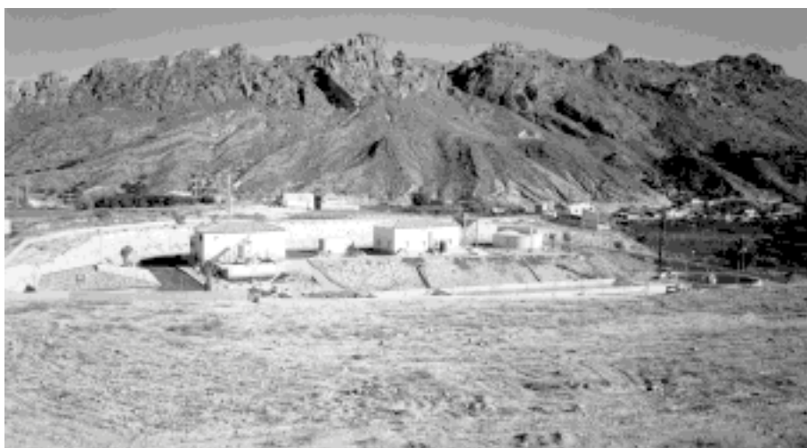
Foto 4.10. EDAR de Abarán en el paraje de Cañada Hidalgo en la margen derecha del Segura.
