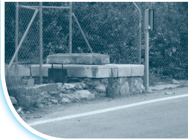
Sifón junto a la carretera que une Blanca y Ojós
