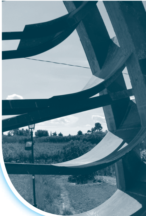
Detalle de las palas curvas noria “El Boticario”
