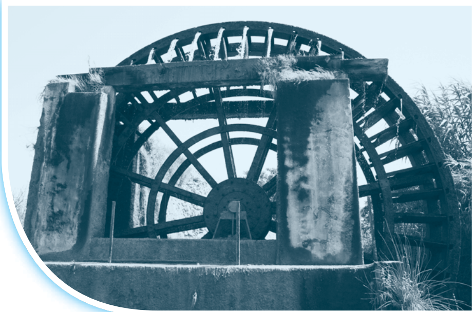
Eje, radios, cangilones y canal de la Noria de 'Hoya de Don García'
