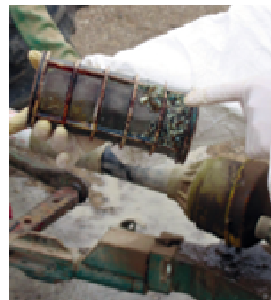
Filtro obstruidas por suciedad
