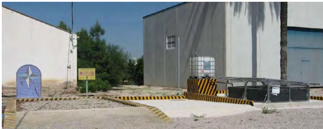
Plataforma de lavado.
