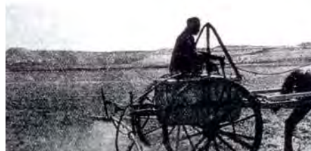
pulverizador de carro con bomba accionada por los ejes
