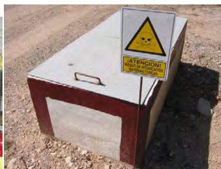
Almacén con colector de desagüe conectado a una fosa impermeable exterior
