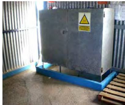
Armario metálico para el almacenamiento de fitosanitarios, con cubeto y suelo de hormigón
