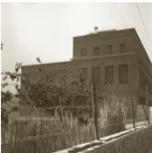
Miguel Ricós. Fachada de la nueva Escuela Elemental de Trabajo en la Avenida de los Astónes, actual calle Juan Carlos I.
