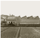
Plano a "mano alzada" de la situación del edificio y fotografía de los terrenos adquiridos.
