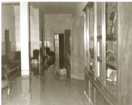
Positos. Estado de las instalaciones tras las inundaciones de octubre de 1973.
