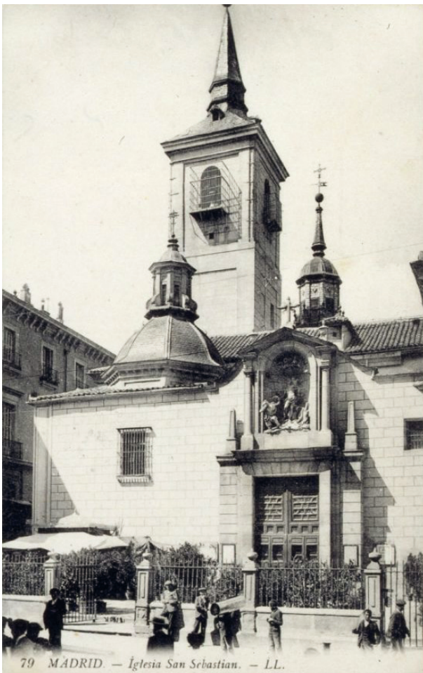
Fig. 3: Fachada de la Iglesia de S. Sebastián (Madrid) (ca. 1919) [fotografía]. Biblioteca Digital Memoria de Madrid http://www.memoriademadrid.es/buscador.php?accion=VerFicha&id=9780
