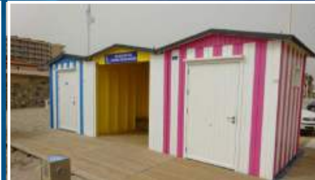
4 Aseo, zona de sombra y vestuario
