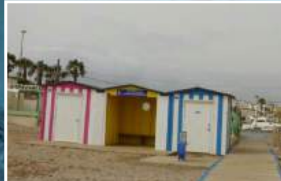
3 Aseo, zona de sombra y vestuario
