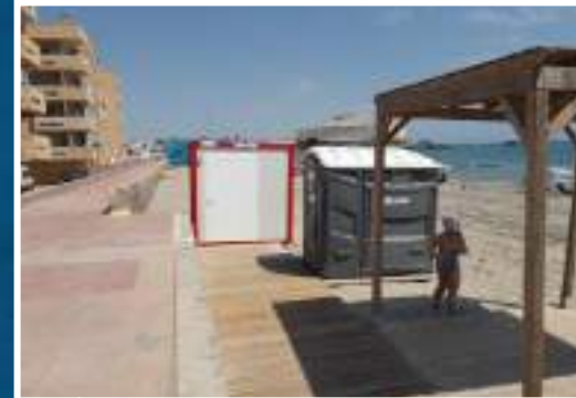
3 Aseo, zona de sombra y vestuario
