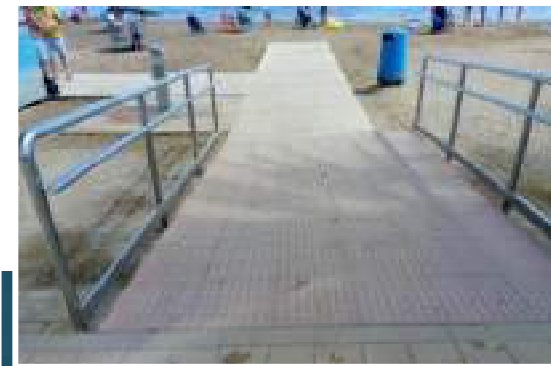
3 Rampa de acceso y pasarela
