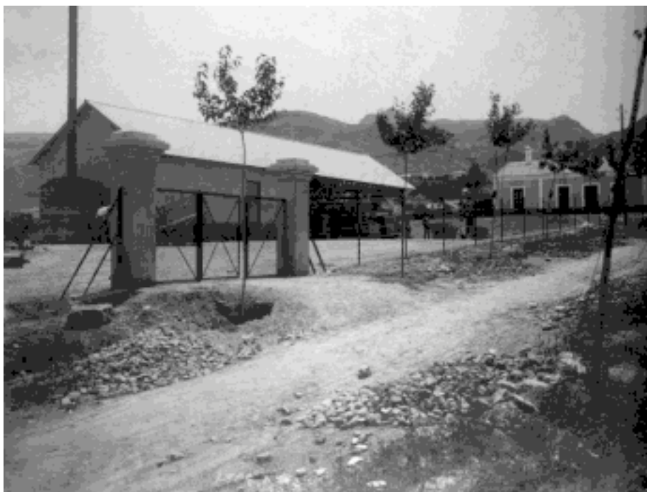
Puerta de entrada de la finca, próxima al ahogadero de vapor
