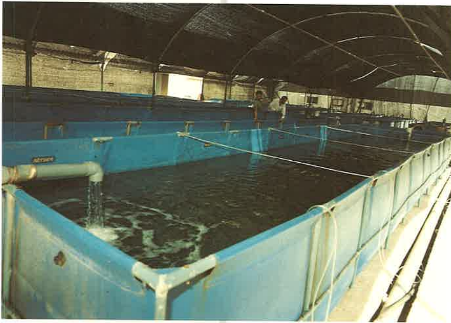
Instalación de preengorde. En un primer plano un tanque de 15.000 l.
