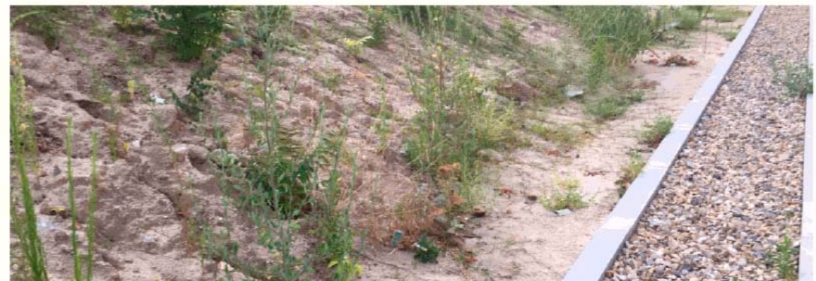
Infiltración en Zanja
