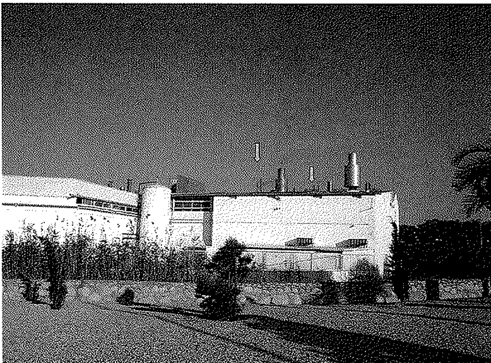
Fotografía nº. 7: Vista, desde la Costera Norte, de salidas de vapor de agua de la recuperación del condensado de las calderas de vapor (día 29/09/2021).
