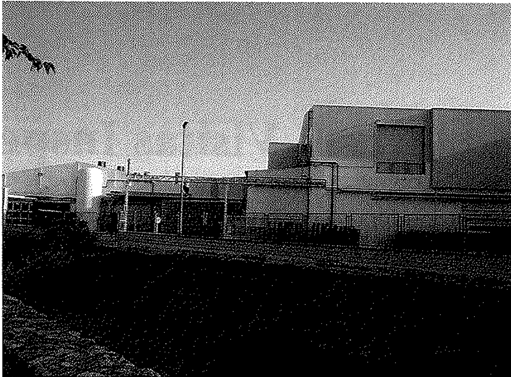
Fotografía n.º 2: Otra vista de la fachada de la actividad desde el Paseo de la Ladera junto a urbanización la Glorieta (día 28/09/2021).
