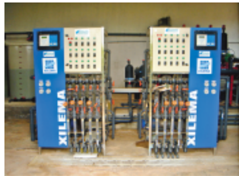
Dos equipos independientes de fertirrigación (hortalizas y frutales).
