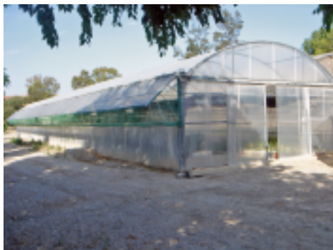
Invernadero tipo multicapilla.
