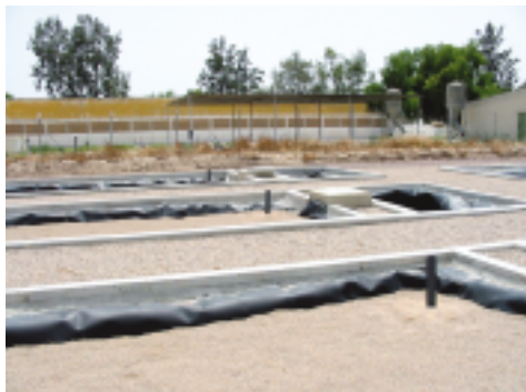
Construcción de balsas para proyecto de depuración de efluentes porcinos con macrofitos.
