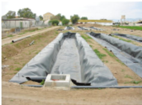
Construcción de balsas para proyecto de depuración de efluentes porcinos con macrofitos.
