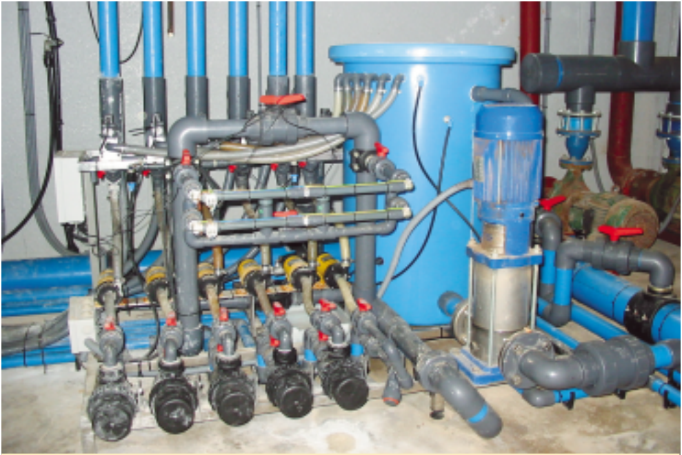
Un cabezal de riego adecuado y en buen estado nos garantizará la correcta dosificación de agua y fertilizantes.
