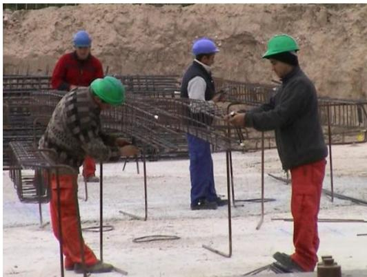
hormigón armado. La duración de la tarea, dependiendo de la longitud de la armadura de que se trate puede variar entre 30 y 60 min. e implica manipulación de cargas, posturas forzadas y ocasionalmente movimientos repetitivos. Los trabajadores transportan los materiales a unos bancos de trabajo metálicos portátiles presentes en la obra y sobre ellos van "cosiendo" la "armadura", que una vez
