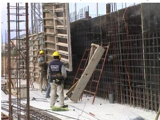
realizar tareas de martilleado y colocación por fijación y presión. Cuando el hormigón que conforma el muro está seco se van retirado las pantallas metálicas y colocando de nuevo para seguir avanzando en el muro, se deben quitar los calzos y los mecanismos de presión (usan martillo para ello), se limpia la pantalla
