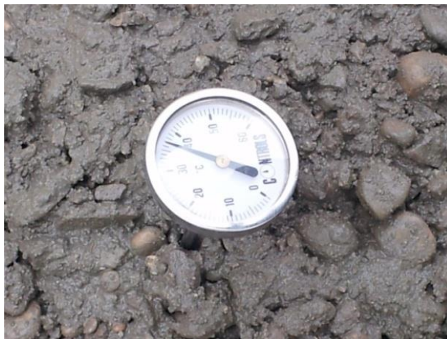
Imagen 3. Control de temperatura del hormigón
