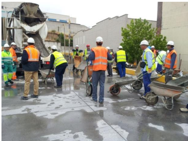
Imagen 2. Toma de muestras de hormigón por los laboratorios participantes
