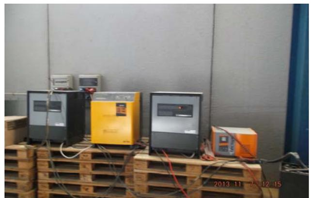
Los equipos de carga y baterías deben estar situados sobre bastidores soporte o bandejas adecuadas, nunca sobre materiales combustibles.
