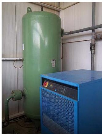
El aire comprimido juega un papel muy importante en la industria actual. Esto se explica por la facilidad de producción, la flexibilidad de distribución y la versatilidad de usos: posicionamiento de pistones, motores neumáticos, válvulas, proyección de pinturas, soplado de plásticos, accionamiento de herramientas neumáticas (percutoras, grapadoras) etc...
