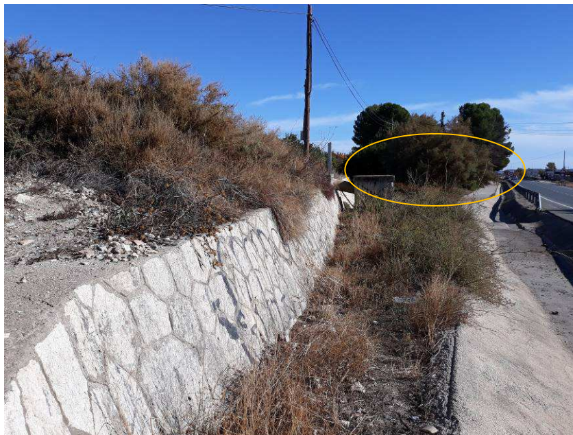
Imagen 7: Vista de E-1 Muro Estación de Mula y ejemplares de tarays a conservar por el Plan Parcial. Foto: Servicio de Información e Integración Ambiental (09.11.2020)
