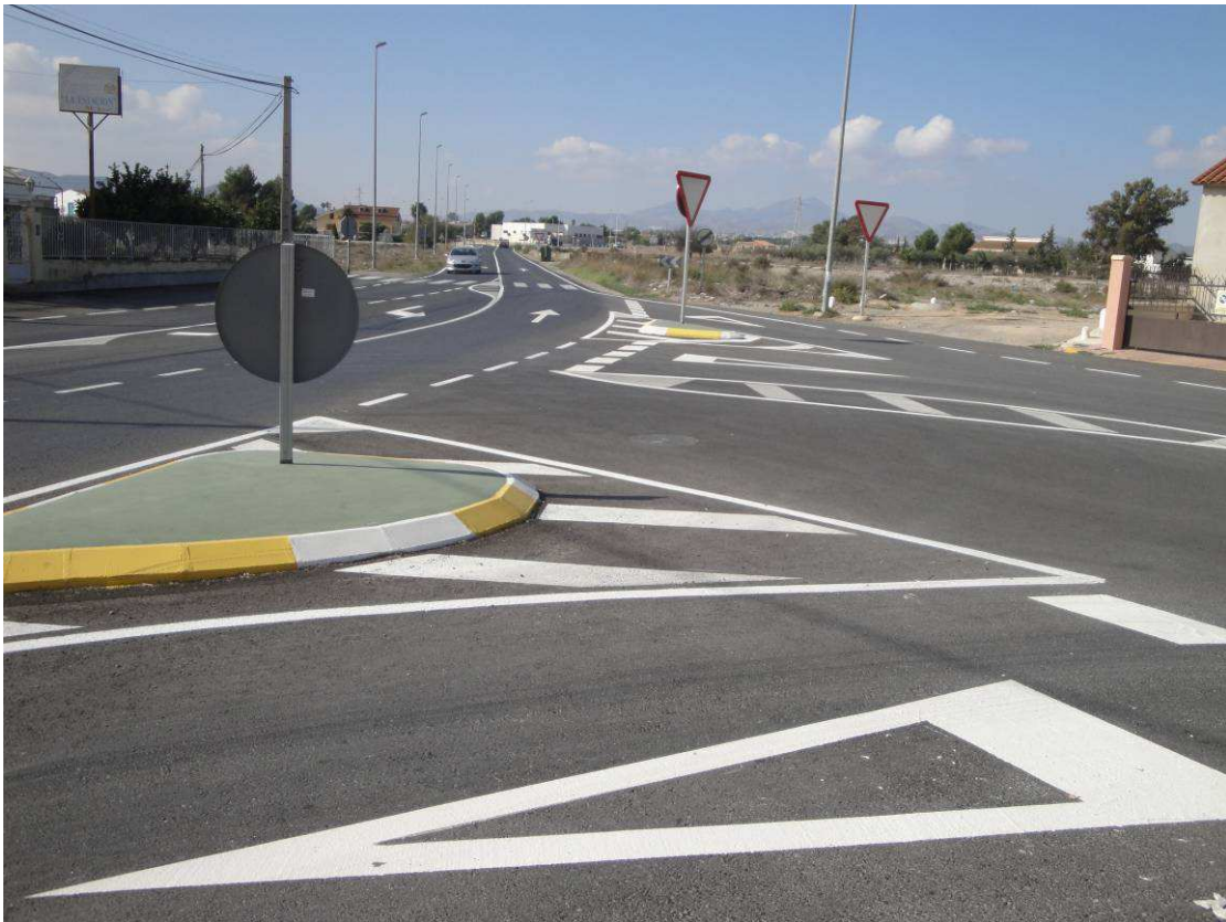
REPOSICIÓN DE FIRME Y ORDENACIÓN DE ACCESOS EN LA CARRETERA RM-D16
