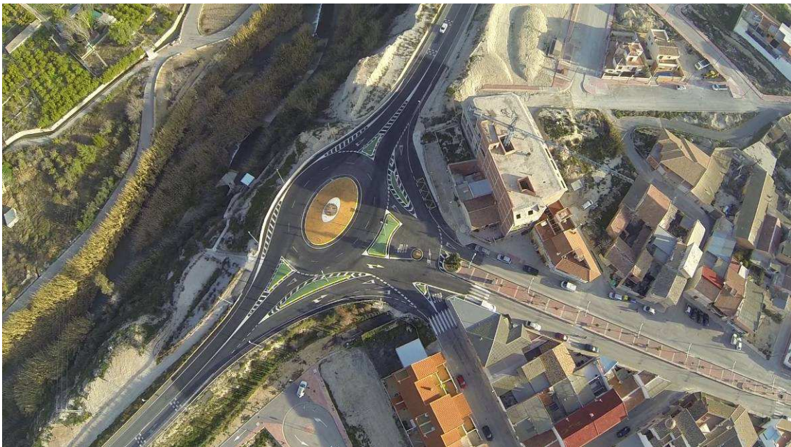
CONSTRUCCIÓN GLORIETA EN INTERSECCIÓN DE LA CARRETERA RM-554 CON EL ACCESO A LA ALGAIDA
